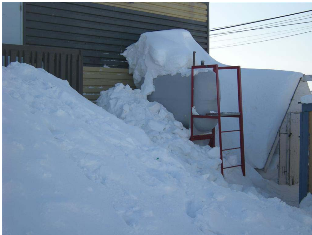
Charge de neige à prendre en considération pour que le système ne soit pas compromis (p. ex. s'agissant des conduites de carburant, des vannes d'isolement, etc.).
