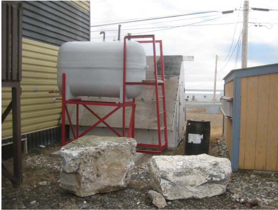
Protection anticollision (roches trouvées sur place).
