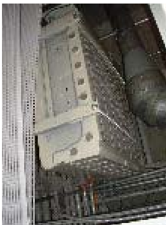
Condenseur Mitsubishi à l'extérieur d'un des locaux de RL
