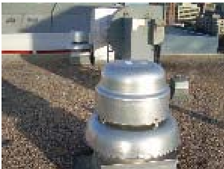
Trois ventilateurs montés sur toit
