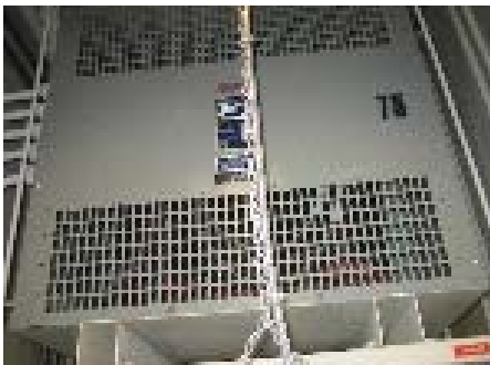
Transformateur secondaire typique
