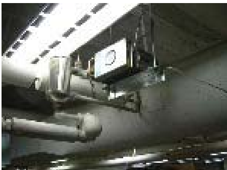
Système typique de dispersion de vapeur
