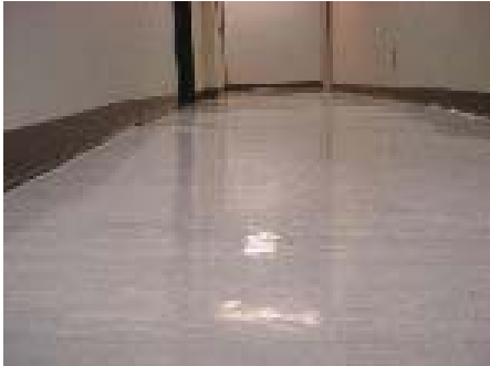
Revêtement de sol en linoléum dans un corridor du sous-sol
