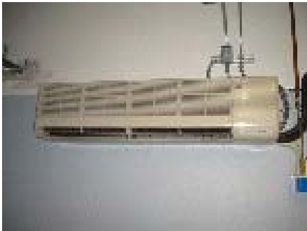
Évaporateur Mitsubishi dans un des locaux de RL
