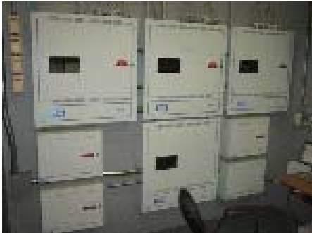
Panneaux du matériel d'alarme incendie
