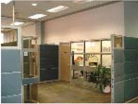
Cloison de bureau vitrée à bâti d'aluminium
