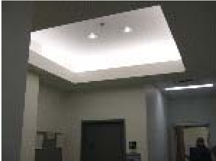
Retombée en plaques de plâtre peinturée avec plafond encastré
