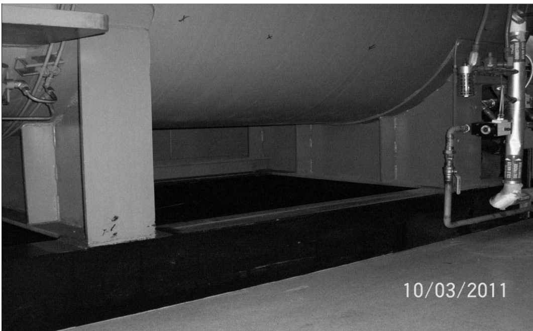
Vue de cote des poutres en I sur lequel l'autoclave est soudé.
