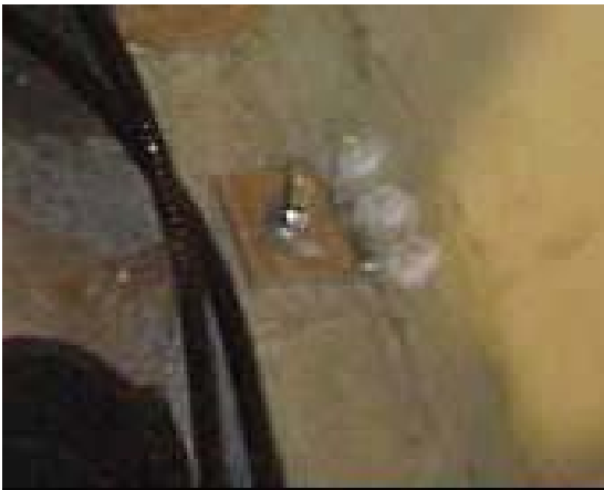
Figure 2 – Montage du radôme à la plate-forme de la tour – plaques en acier galvanisé
