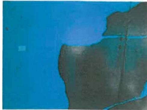
Photo 8 Formation de moisissures observées par endroits sur la surface de murs peints dans l'entrée arrière du camp
