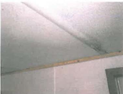
Photo 5 Moisissures observées sur le plafond de la cuisine
