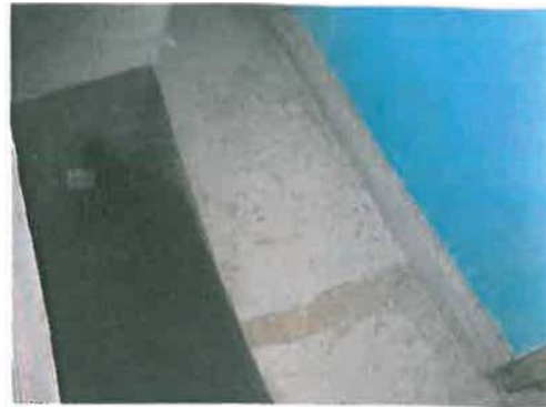
Photo 2 Moisissures observées par endroits sur le plancher dans les corridors du camp
