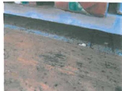
Photo 6 Moisissures observées sur le plancher de la cuisine
