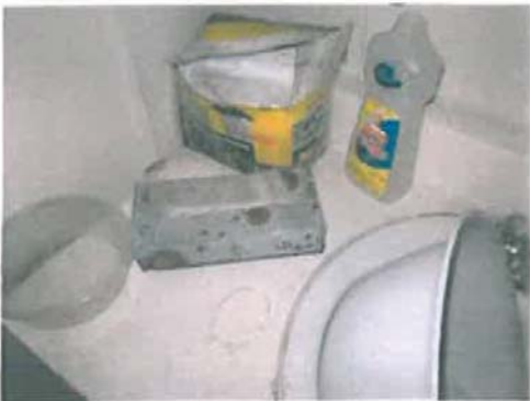
Photo 9 Formation de moisissures observées sur le comptoir de la salle de bain
