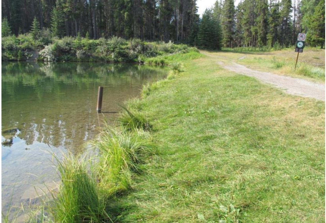
Photo 6 : Barrage ouest – Côté amont de la digue – Vue sur le sud
