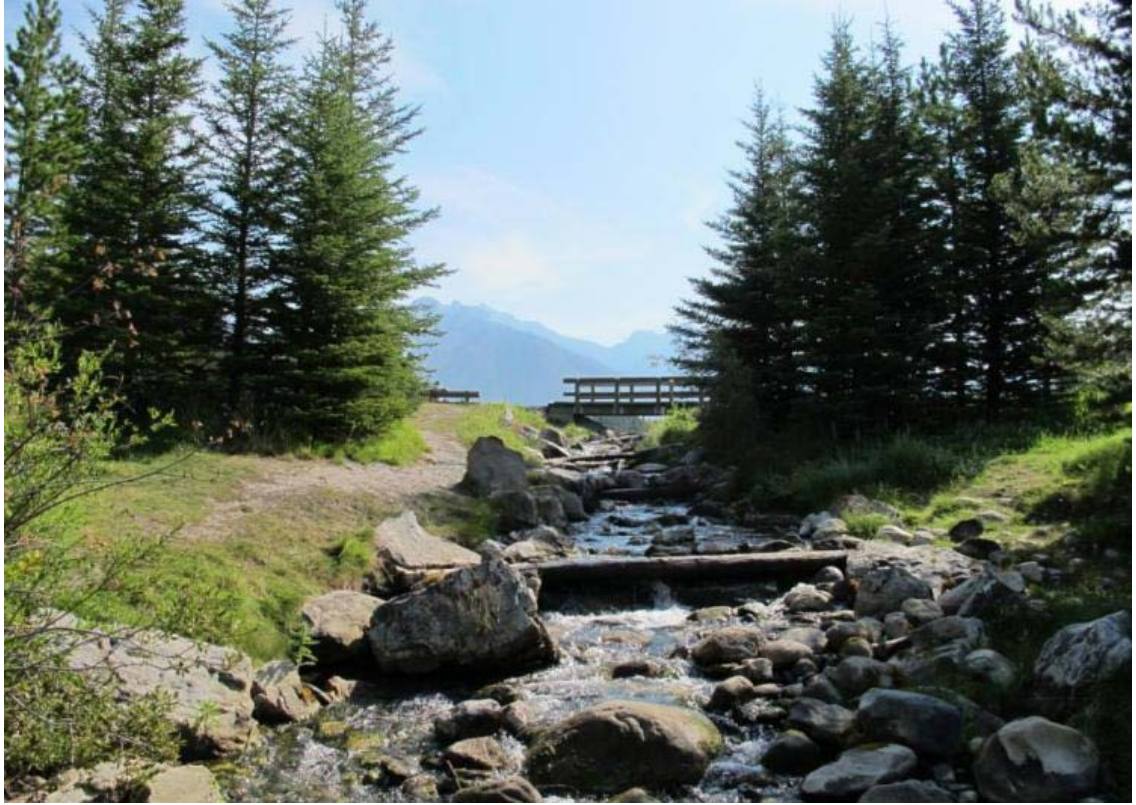
Photo 11 : Barrage ouest – Ruisseau en aval du barrage – Vue sur le déversoir
