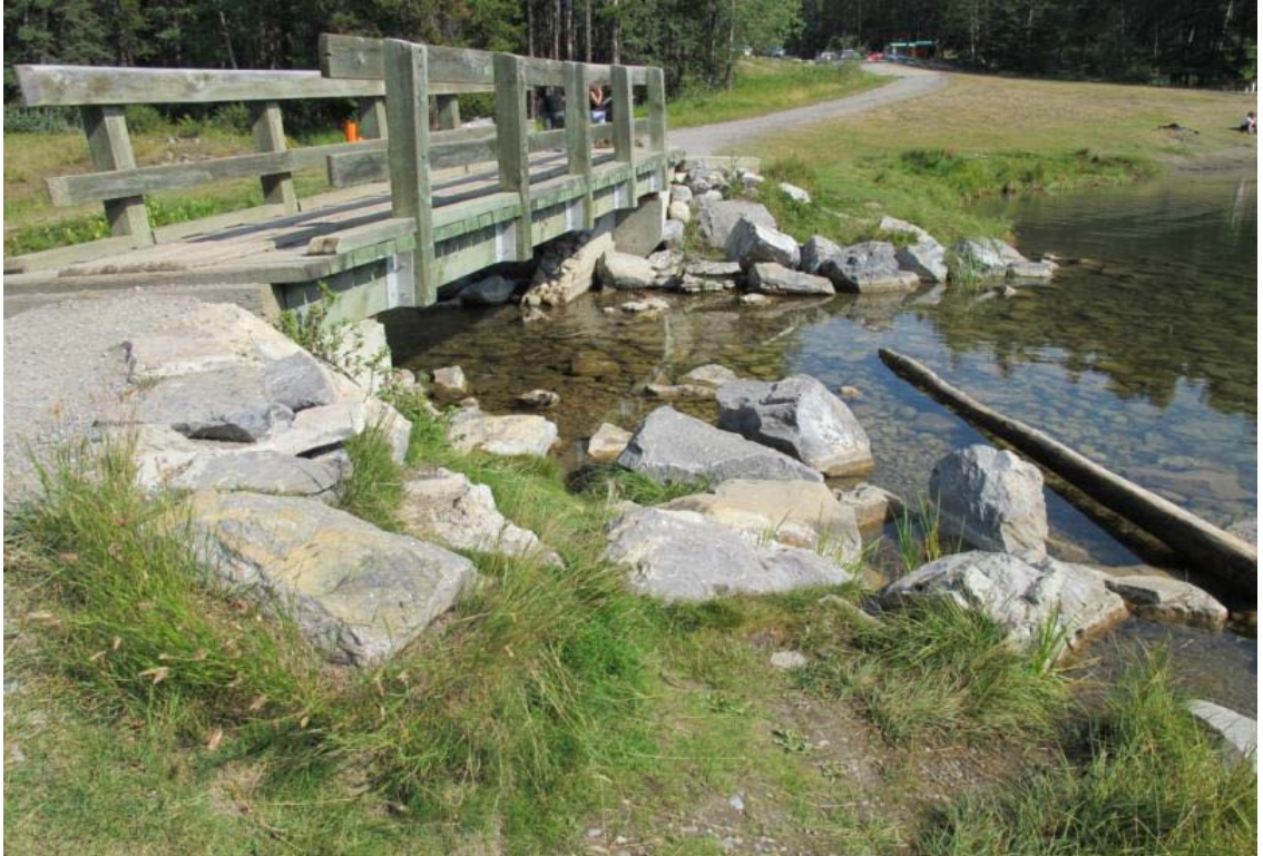
Photo 4 : Barrage ouest – Côté sud du déversoir
