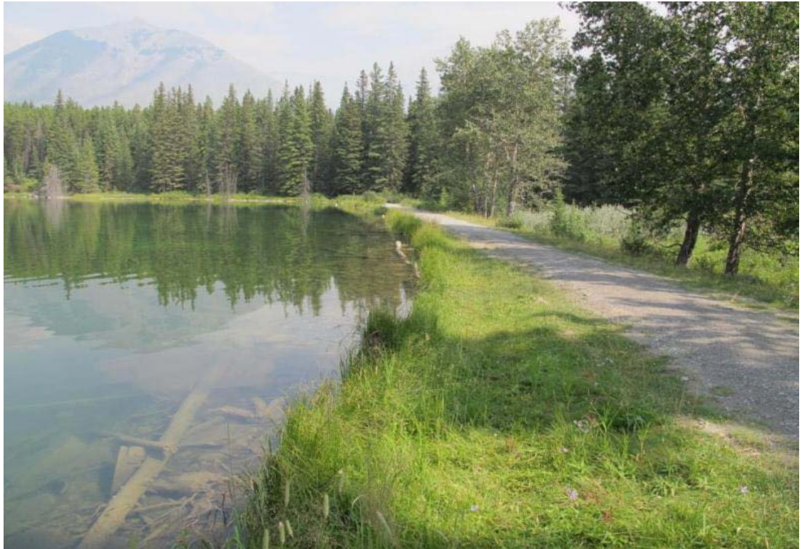
Photo 17 : Barrage est – Vue sur l'appui latéral est
