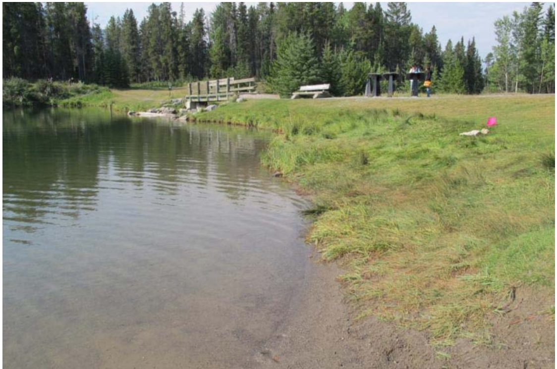
Photo 2 : Barrage ouest – Vue sur l'ouest depuis la plage
