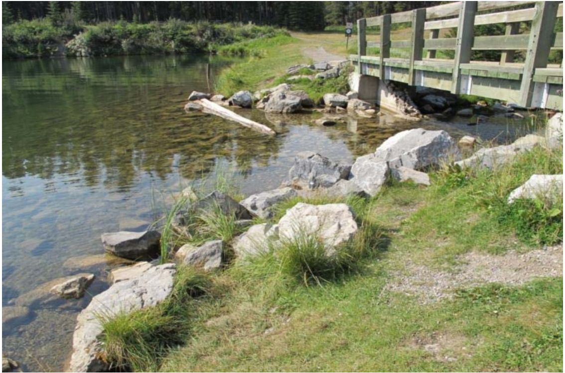
Photo 3 : Barrage ouest – Côté nord du déversoir
