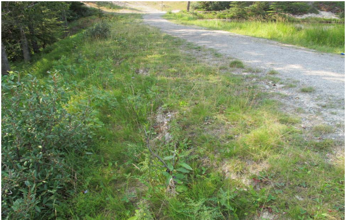
Photo 25 : Barrage est – Vue en direction sud
