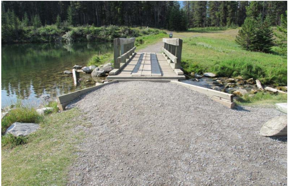
Photo 5 : Barrage ouest – Pont du déversoir – Vue sur le sud
