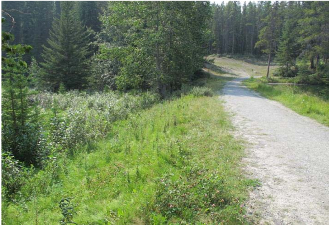
Photo 23 : Barrage est – Végétation du côté aval de la digue, à l'extrémité ouest du barrage
