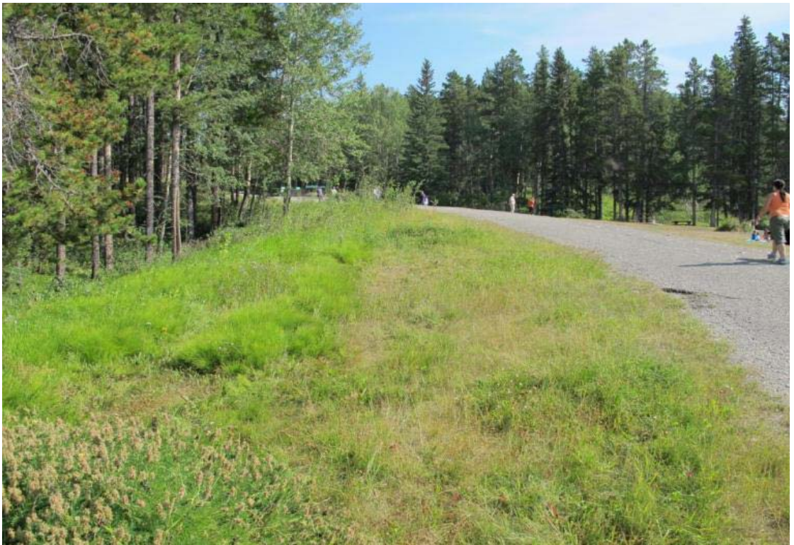
Photo 14 : Barrage ouest – Côté aval de la digue – Vue sur le nord
