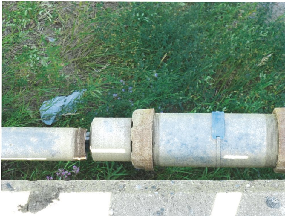
11.2 – Repair Electrical Conduit
