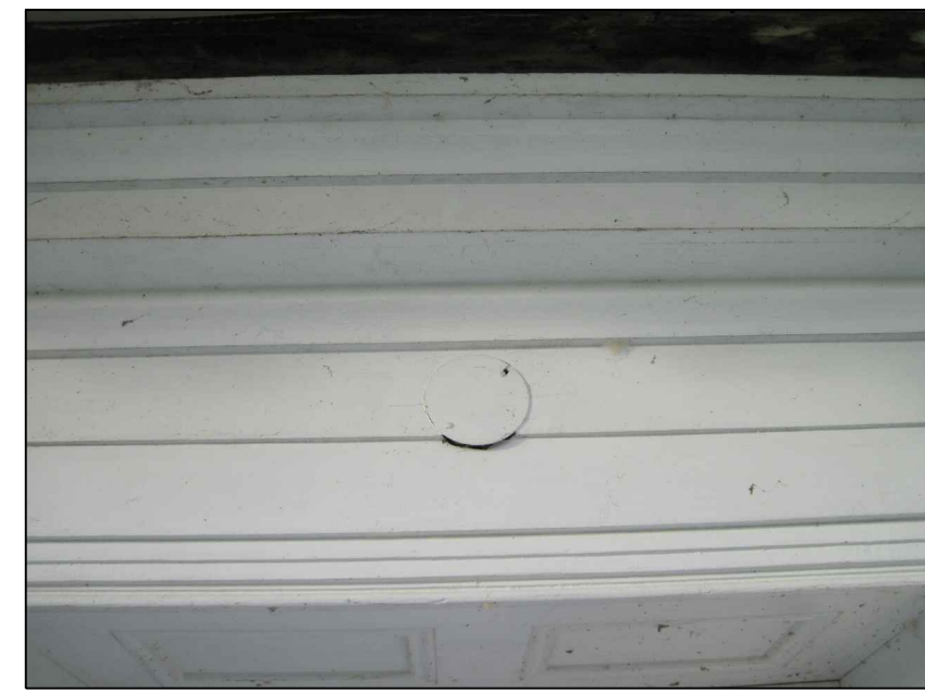
TROU DE L'ANCIEN LUMINAIRE ÉCHELLE: AUCUNE
