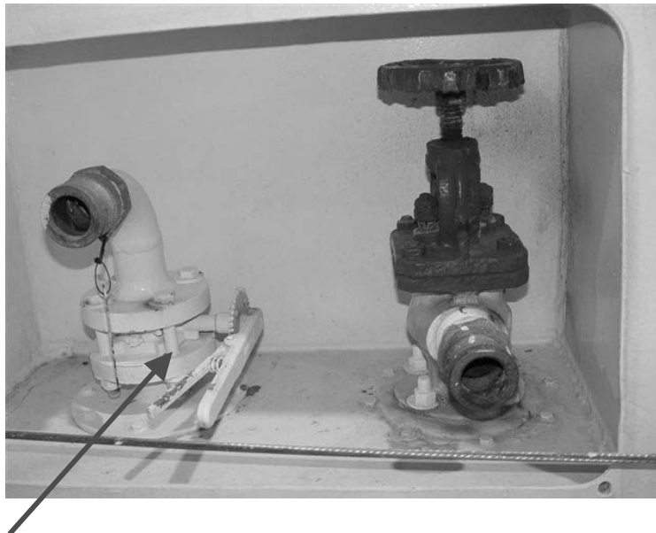
Figure E-04-1 – Évent de mise à l'air libre du carburant
