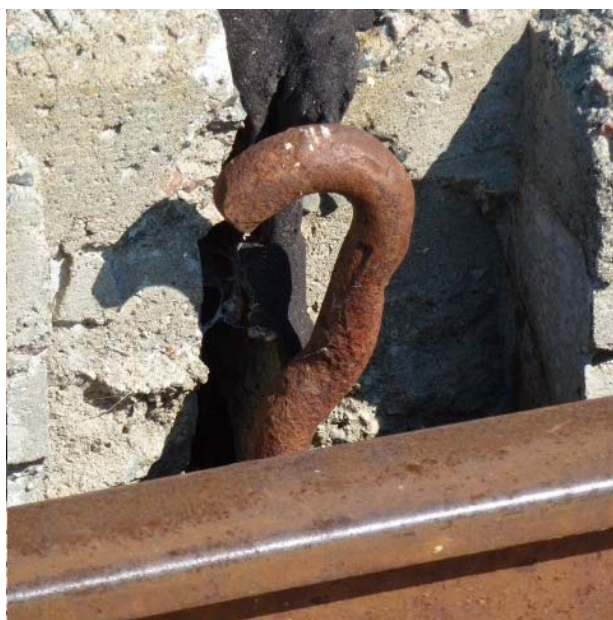
Figure 2 - Un ancrage de tablier endommagé. La photo montre qu'une des deux ancrages endommagés. Elle est donnée à titre indicatif et pourrait ne pas être entièrement représentatif de l'autre ancrage endommagé.
