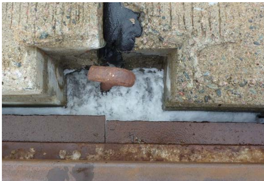
Figure 3 - Un ancrage de tablier endommagé, vue de dessus. La photo montre qu'une des deux ancrages endommagés. Elle est donnée à titre indicatif et pourrait ne pas être entièrement représentatif de l'autre ancrage endommagé.
