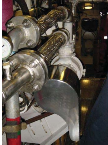
HD-05-Fig. 2 – Tuyauterie de la pompe à incendie
