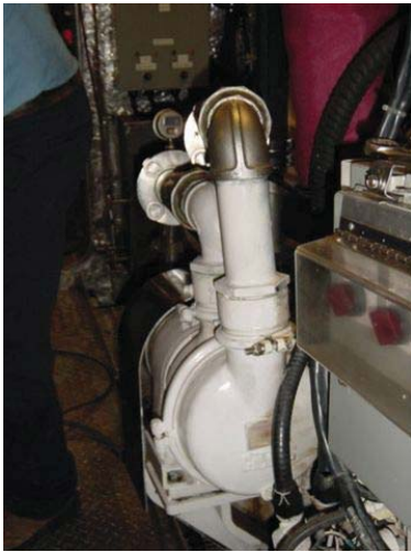
HD-05-Fig. 1 – Pompe à incendie (vue vers l'arrière)
