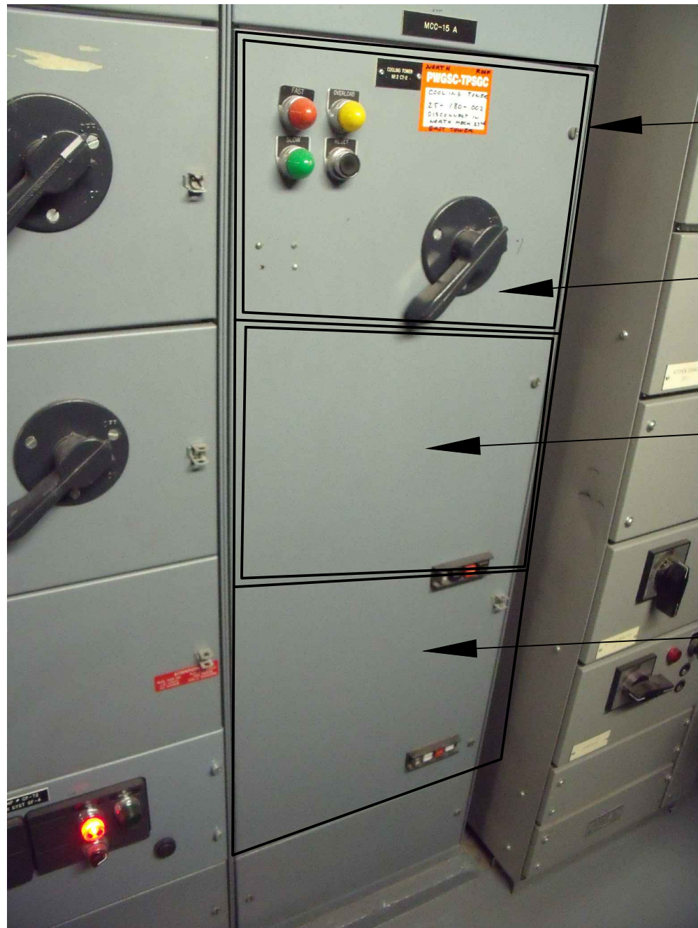
3 E1 DÉMARREUR DE MOTEUR DE TOUR DE REFROID. EXISTANT (40+10 hp) PAS À L'ÉCHELLE
