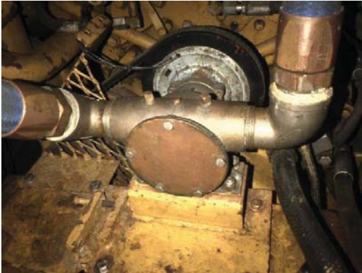
HD-05-Fig. 1 – Pompe à incendie (vue vers l'arrière)
