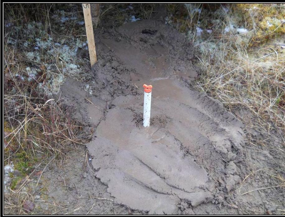
**Photo 5 :** Tube d'observation installé dans le forage TF-05-12.
