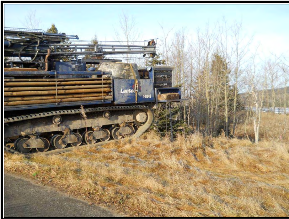
Photo 4 : Installation au forage TF-04-12.
