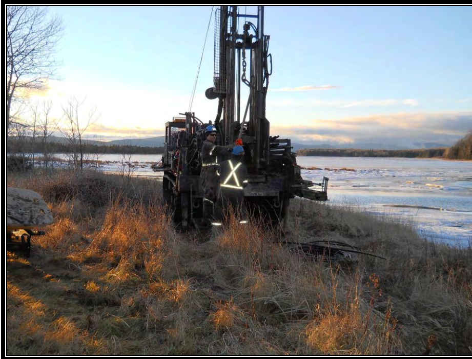
Photo 1 : Réalisation du forage TF-01-12 (3 décembre 2012).
