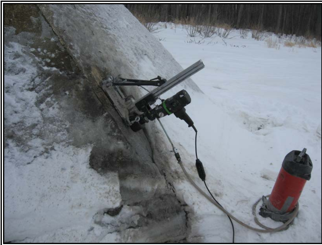
Photographie no 9 : Traverse amont FA. Pendant les travaux. Carotte C-1.
