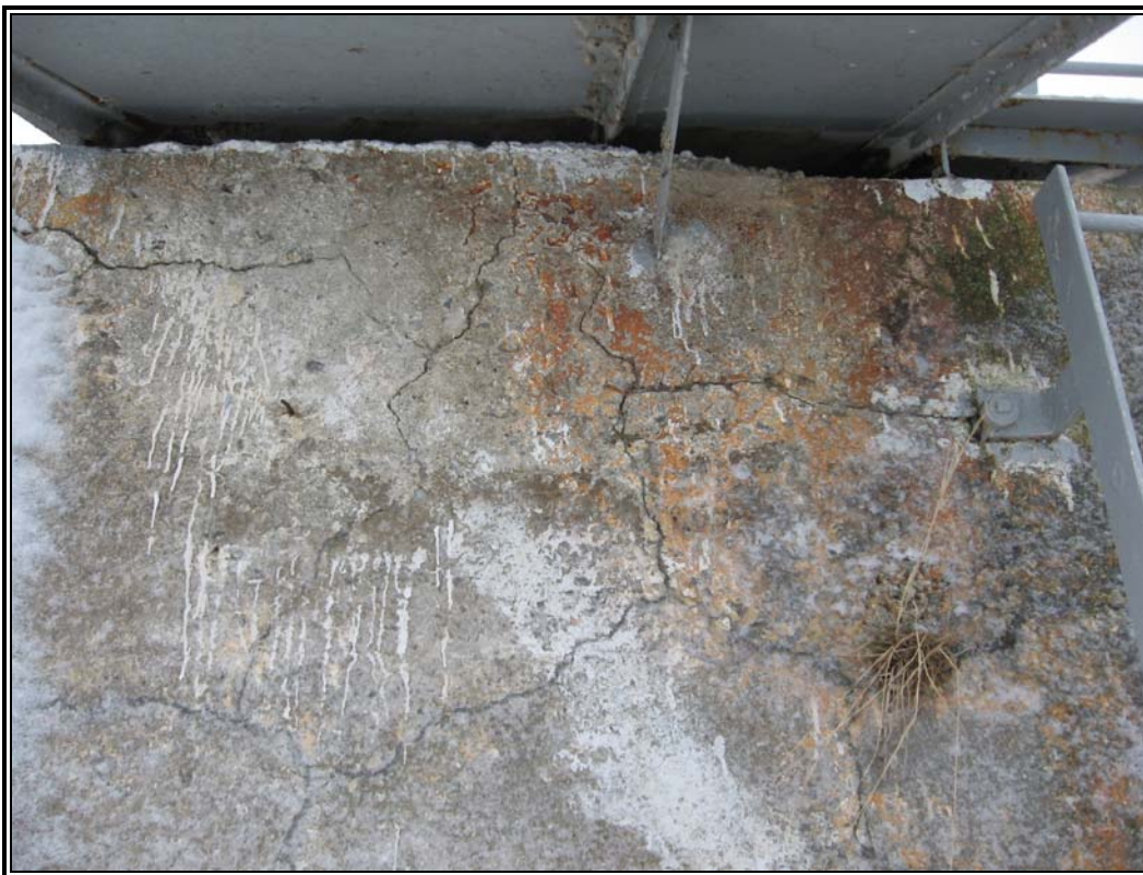
Photographie no 6 : Traverse amont FA. Fissures de la base du béton hors-sol du côté est.
