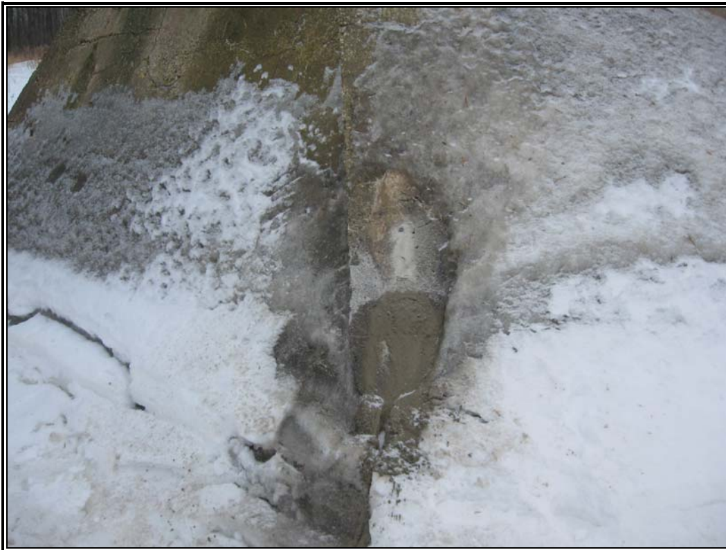
Photographie no 13 : Traverse amont FA. Réparation de la perforation. Carotte C-1.
