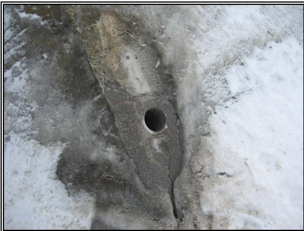
Photographie no 10 : Traverse amont FA. Pendant les travaux. Carotte C-1.
