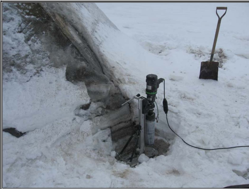
Photographie no 11 : Traverse amont FA. Pendant les travaux. Carotte C-2.
