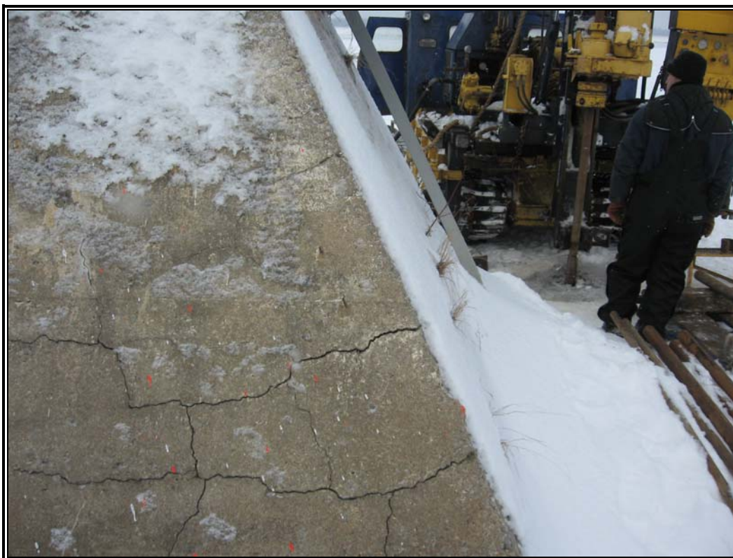
Photographie no 5 : Traverse amont FA. Fissures de la base du béton hors-sol du côté sud.
