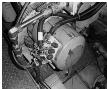
Figure L-01-3 : Alternateur de bâbord
