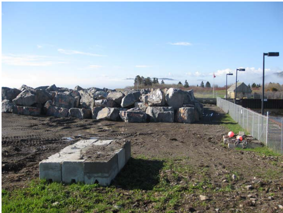
Photo 7 - Pierre de calibre 8 à 12 t.m. (quantité 3200 t.m.) fournie par TPSGC. Elle est située près du havre.
