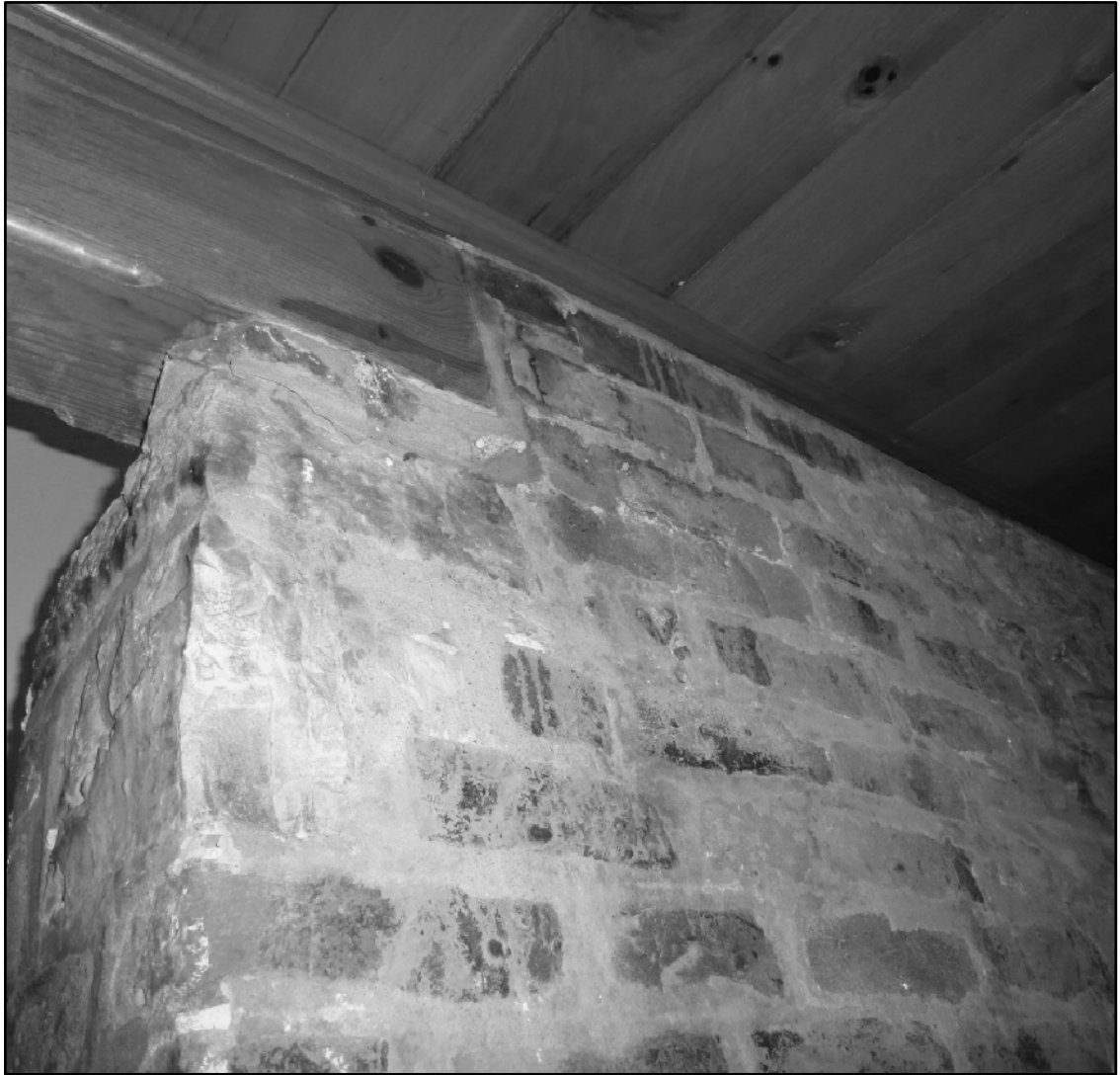
7 PHOTO - LINTEAUX DE BRIQUE ET DE BOIS A500 N.T.S.
