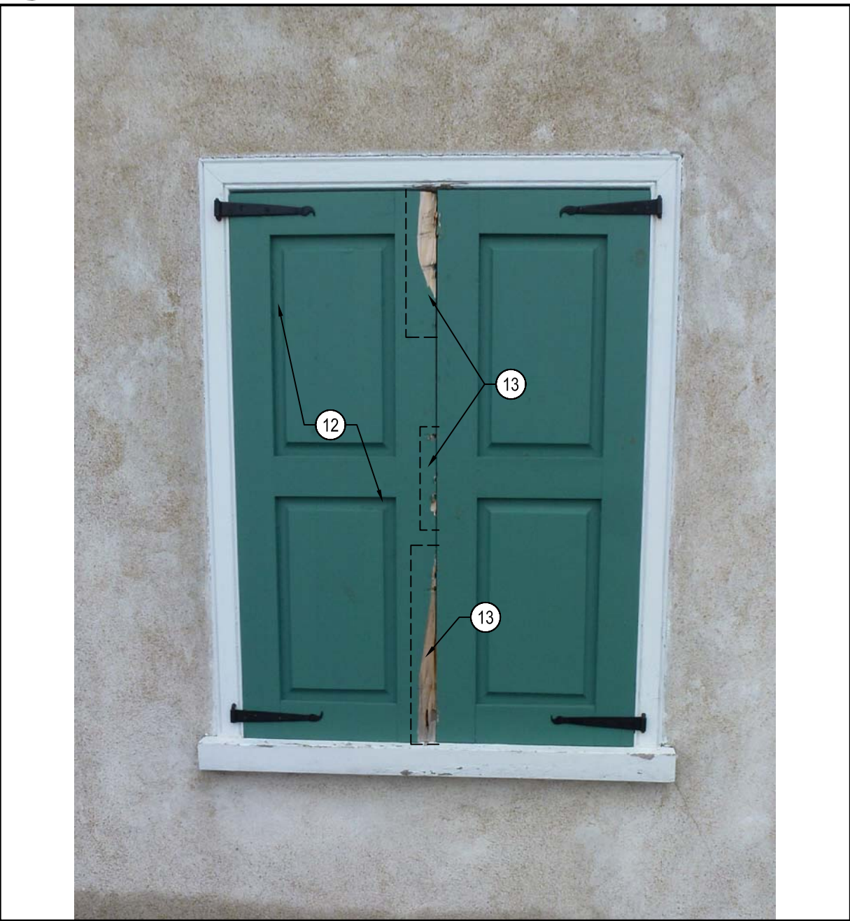
7 A503 PHOTO - FENÊTRE 110 - VOLETS À RÉPARER N.T.S.
