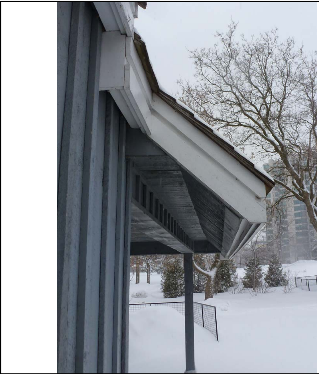
9 BORDURE DE TOIT EXISTANTES (TOILETTES) A501 N.T.S.
