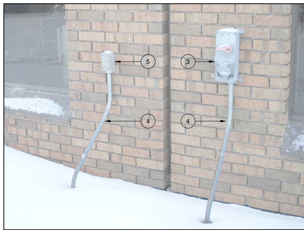
2 E005 / ÉCHELLE / SCALE: AUCUNE / NONE PRISES EXTÉRIEURES ET CONDUITS À REMPLACER / CONDUITS AND EXTERIOR RECEPTACLES TO REPLACE
