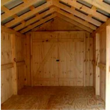
Les feuilles de tôle sont vissées directement sur les chevrons qui eux sont installés à 24" centre. La tôle est visible de l'intérieur de la cabane (côté blanc). / The metal sheets are screwed directly to the rafters. Trusses are 24" center. The metal sheet is visible from inside the cabin (white side).
