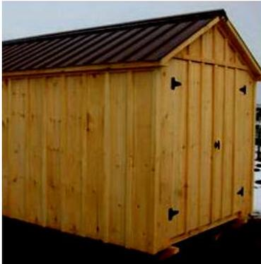
Les planches ont 1" d'épaisseur et de 12" de largeur. Les latte de bois qui recouvrent les joints des planches ont 1" d'épaisseur et 2" de largeur. / The boards are 1" thick and 12" wide. The batten that covers the joints of the boards is 1 " thick and 2" wide.
