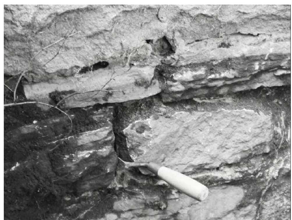
⑨ Fondation pierre moellon / Rubble stone foundation A-07 N.A.
