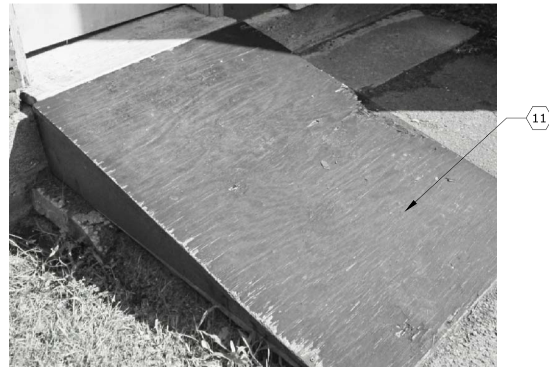
⑦ Rampe en bois existante / Existing wood ramp A-07 N.A.
