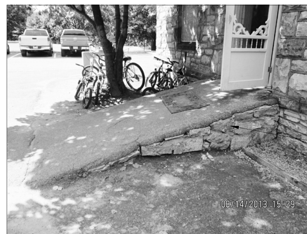
① Rampe existante / Stone existing ramp A-07 N.A.
