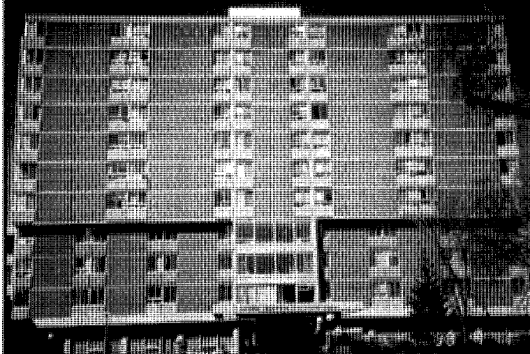
Photo 3 : Exemple de logements-services — Rimmer House au 8 e étage d'un immeuble pour les aînés, Winnipeg (Man.)
