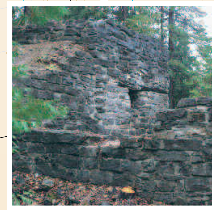
Lime Kiln / Le four à chaux
