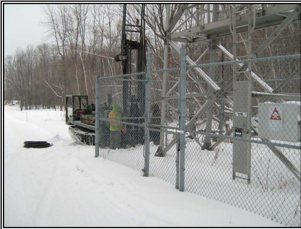
Photographie no 3: Site de Nicolet FP pendant le forage F-04.
