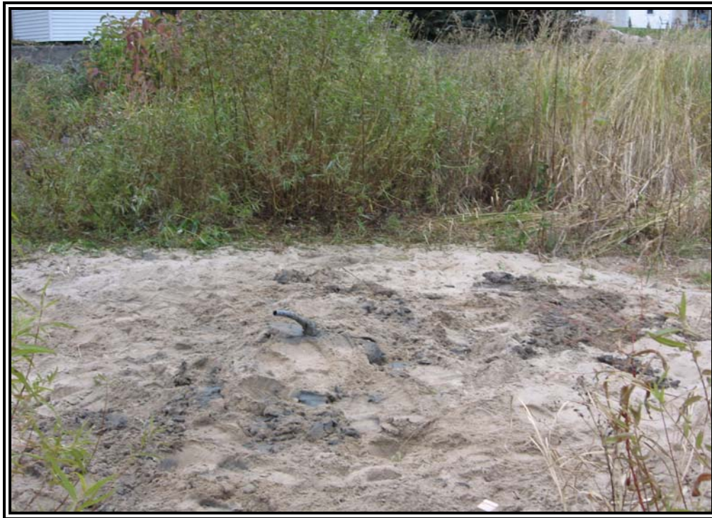
Photographie no 3: État des lieux après la réalisation du forage F-01.
