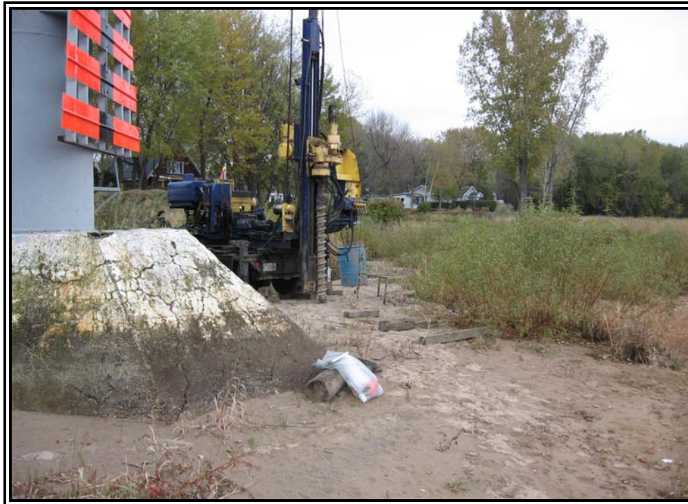
Photographie no 1: Emplacement de la foreuse au sud de la structure existante.
