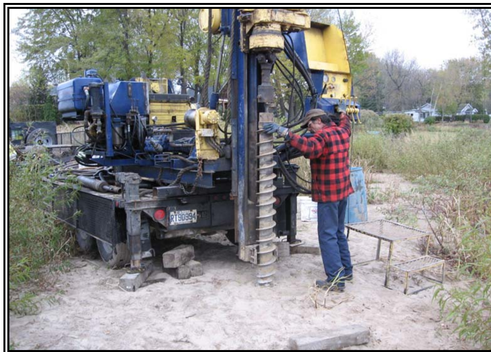
Photographie no 2: Réalisation du forage F-01.
