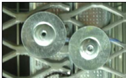
Figure 5 : Exemple de jointure de treillis entrecroisés, rivetés
