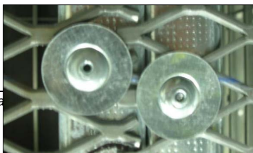
Figure 4 : Rivetage des tôles ou du treillis
