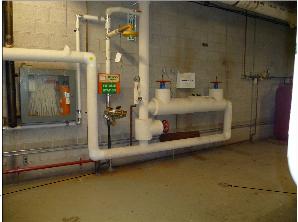
3 MF100 PAS À ÉCHELLE LOCAL DE MÉCANIQUE AU SOUS-SOL – AILE COMMUNE – EMPLACEMENT PROPOSÉ DE POMPE D'INCENDIE
