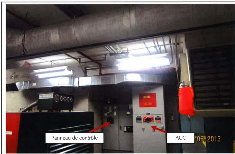
4 – PANNEAU DE CONTRÔLE DE LA GÉNÉRATRICE, ACC EXISTANT, CONDUIT DE VENTILATION ET PRISE D'AIR
