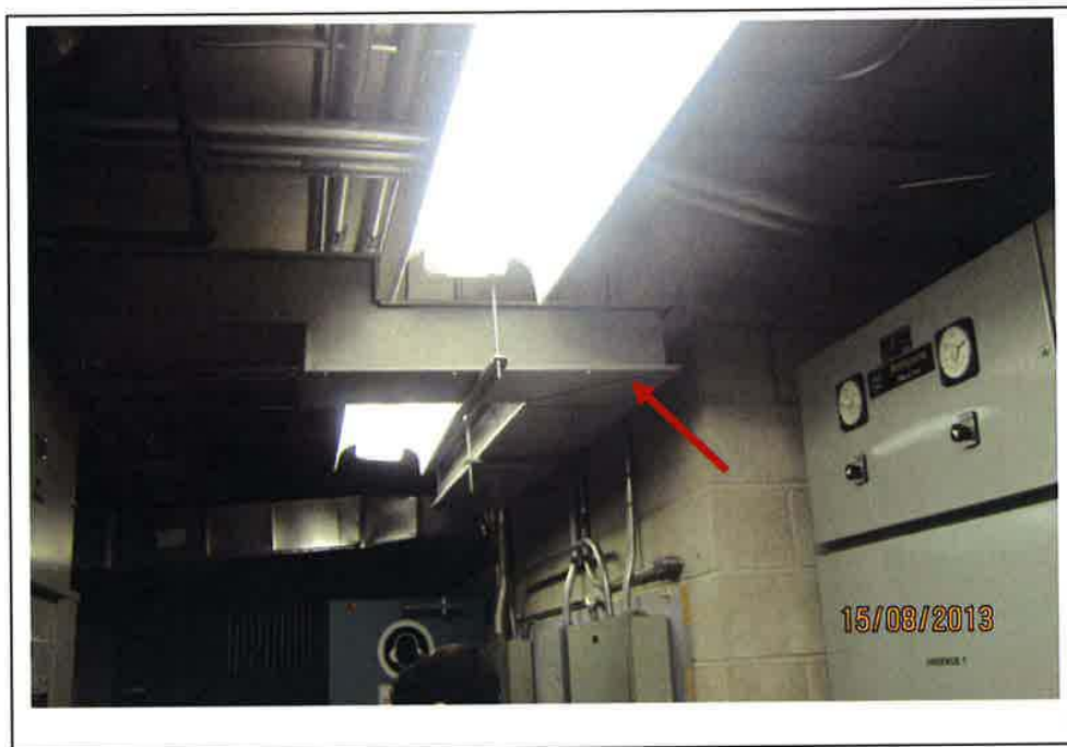
13 – BARRES BLINDÉES DE L'ALIMENTATION NORMALE DANS LA SALLE ÉLECTRIQUE ET CDU
