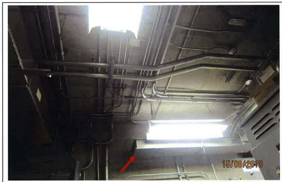
11 – BARRES BLINDÉES DE L'ALIMENTATION NORMALE DANS LA SALLE ÉLECTRIQUE
