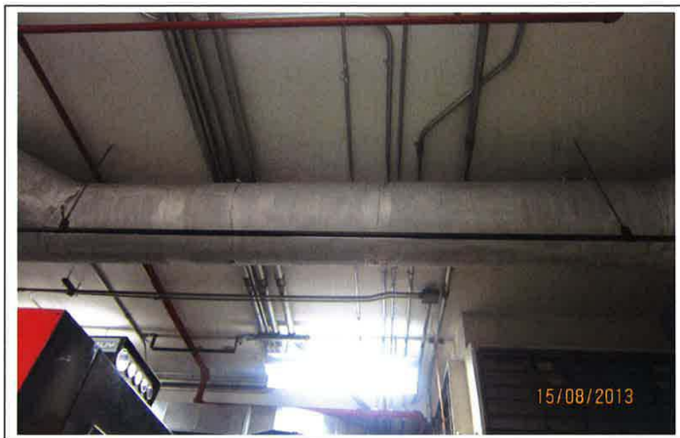
5 – VUE DU PLAFOND (CONDUIT ÉCHAPPEMENT GÉNÉRATRICE)
