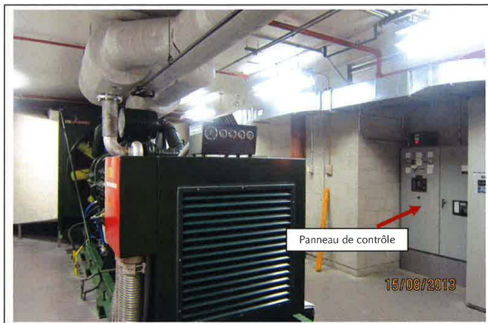
3 – GÉNÉRATRICE, SILENCIEUX, PANNEAU DE CONTRÔLE
