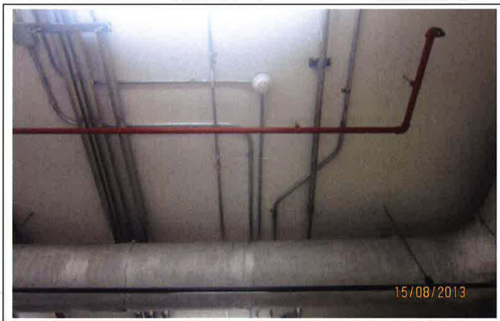
6 – VUE DU PLAFOND (CONDUIT ÉCHAPPEMENT GÉNÉRATRICE)
