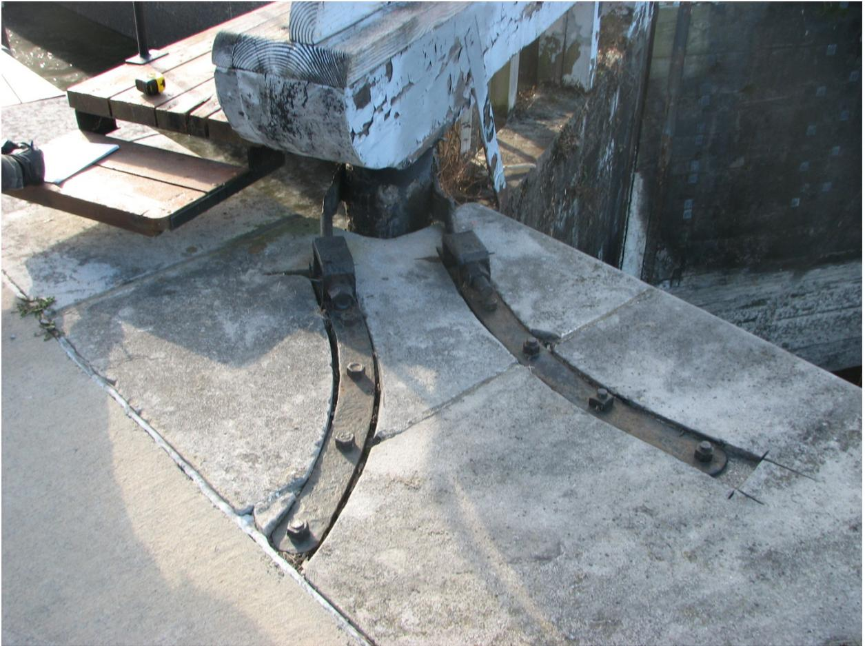
B6 – Principe d'attache des collets
