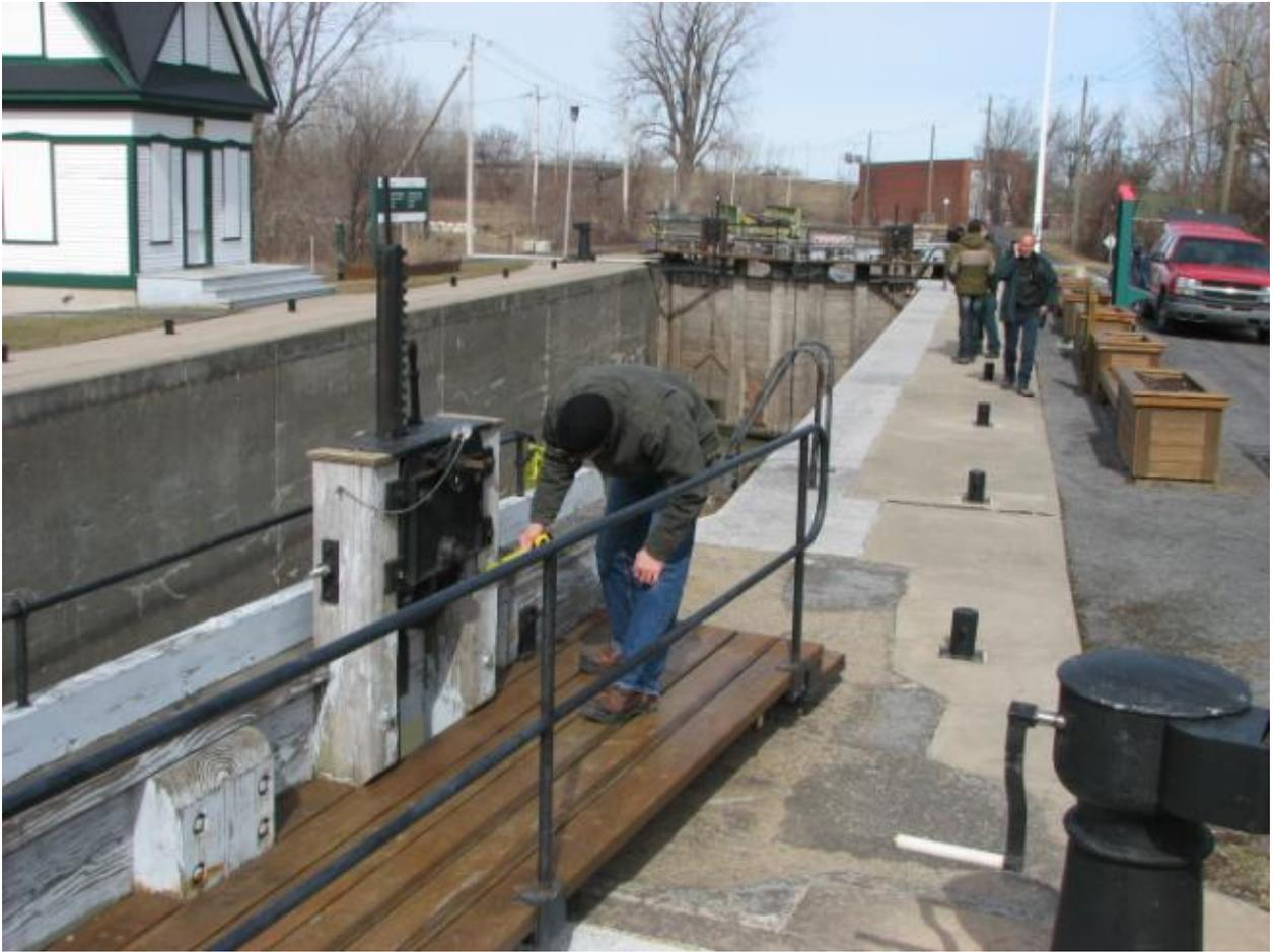
A5 – Mécanisme d'ouverture de la vanne guillotine en rive droite
