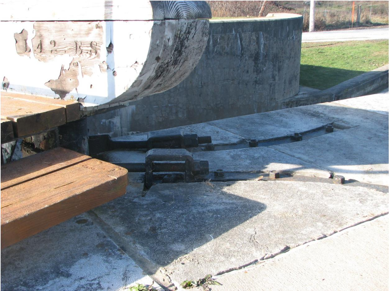
B7 – Principe d'attache des collets
