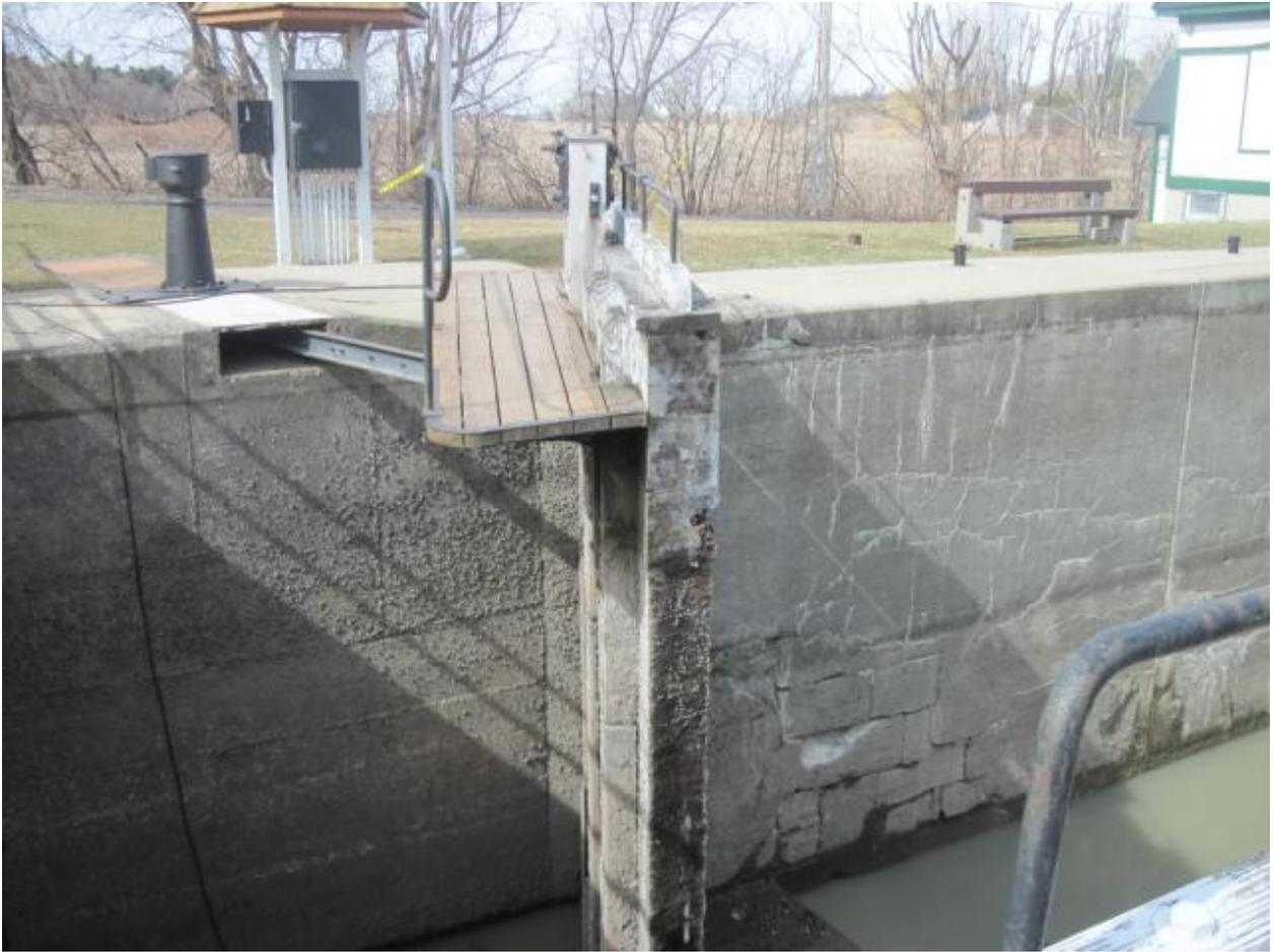
A6 – Mécanisme d'ouverture de la porte en rive gauche
