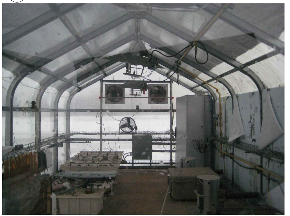
C SERRE - VUE INTÉRIEURE GREENHOUSE - INTERIOR VIEW
