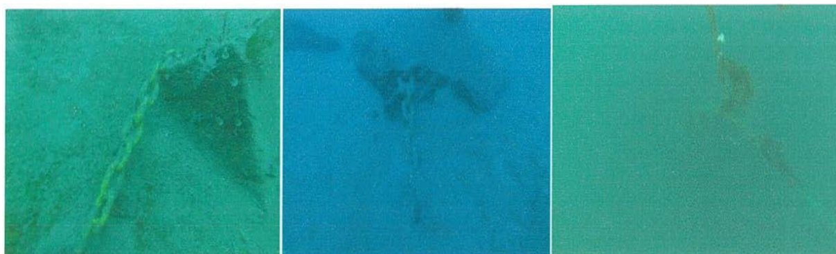
Bloc d'ancrage enfoui. Bouée Est à l'île Shuttle. Bloc d'ancrage Ouest.
