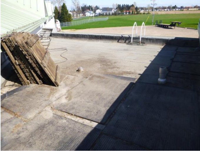
Toit plat arrière – Est
