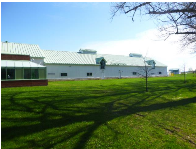
Vue avant – Ouest
