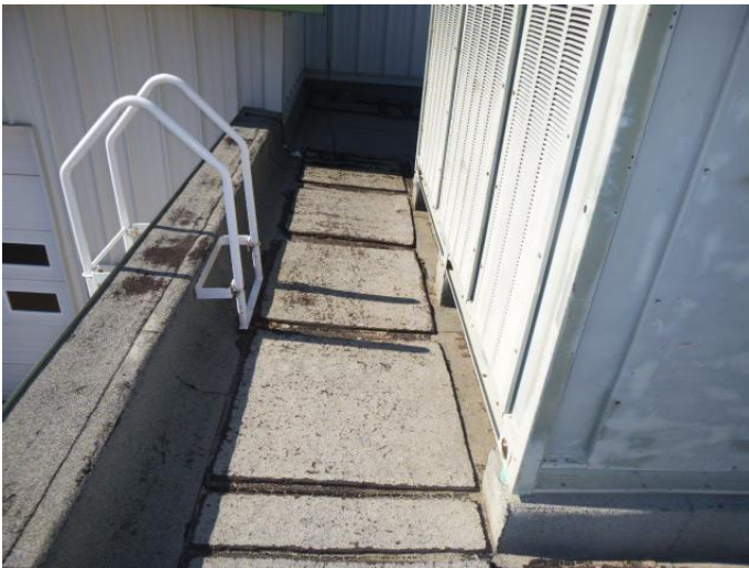
Toit plat arrière – Est
