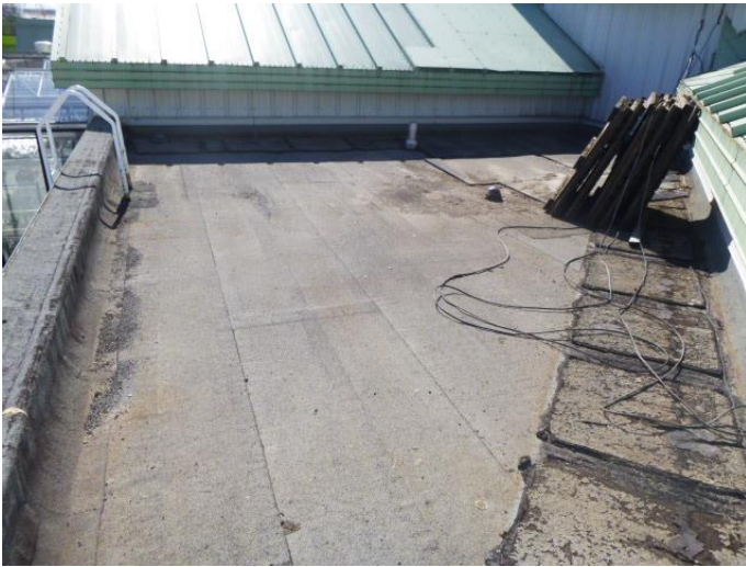
Toit plat arrière – Est
