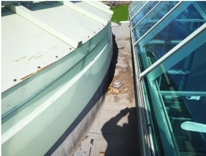
Toit plat avant – Est
