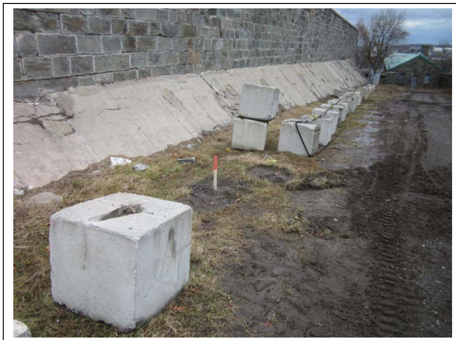
Photo 2 : Position du forage F-5; vue direction nord-est.
