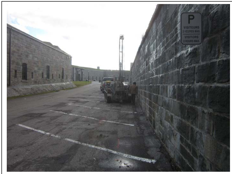
Photo 1 : Position du forage F-1; vue direction sud-ouest.
