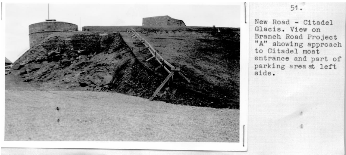
Figure 4 : Travaux réalisés en 1939 à l'extrémité nord-est de la contrescarpe
