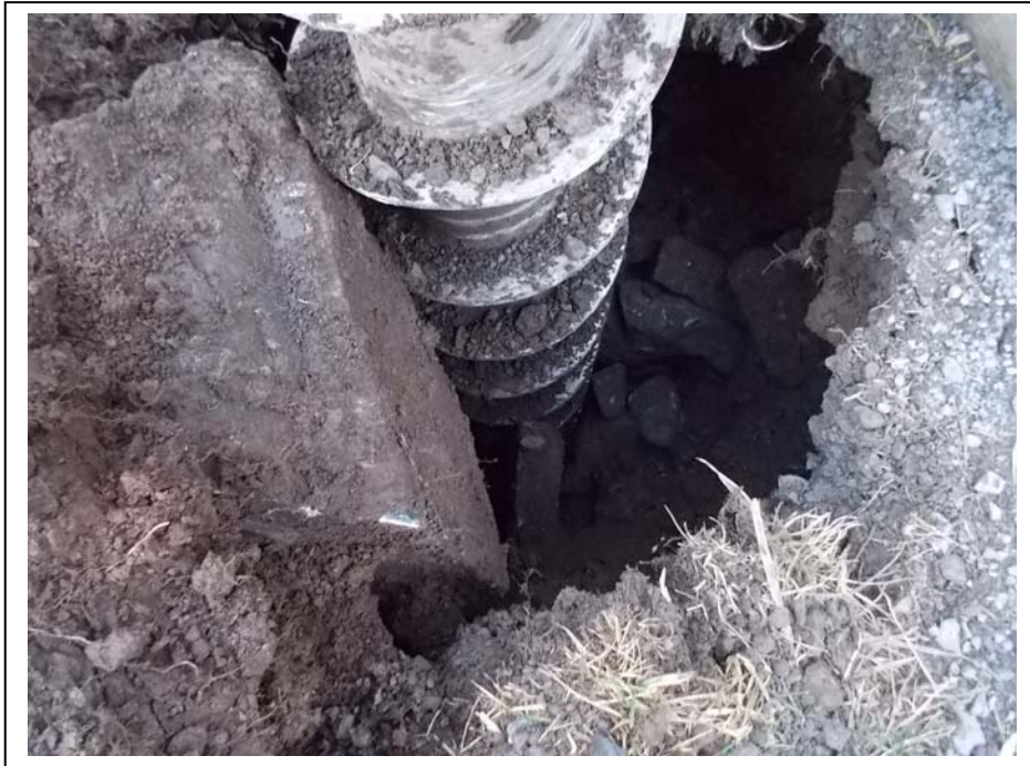
Photo 3 : Vides dans le remblai lors de la réalisation du forage F-14.
