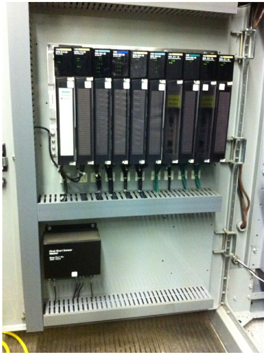
4 EXISTING GENERATOR PARALLELING CONTROLLER E1 SCALE: N.T.S.
