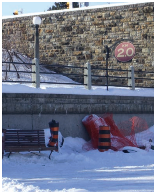
Repère kilométrique fixé à un garde-fou (Site Pretoria, 2,0 km)
