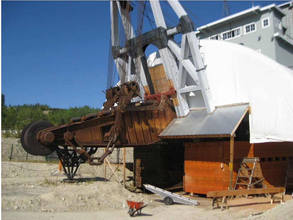
Figure 3: Support au sol du bras d'excavation
