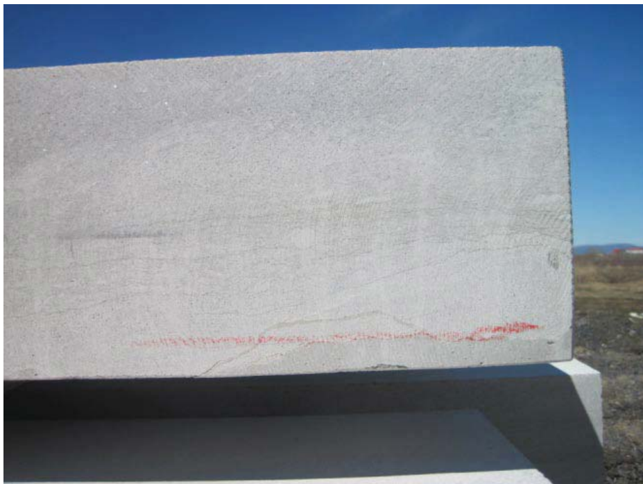
Fig 2. Réparation époxydique inacceptable le long d'un rebord latéral inférieur et ce, compte tenu d'une brisure collée
