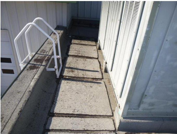
Toit plat arrière – Est
