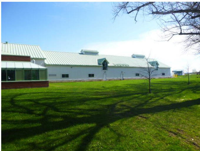
Vue avant – Ouest
