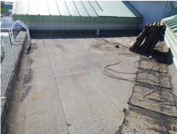
Toit plat arrière – Est
