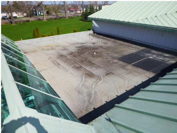
Toit plat avant – Est
