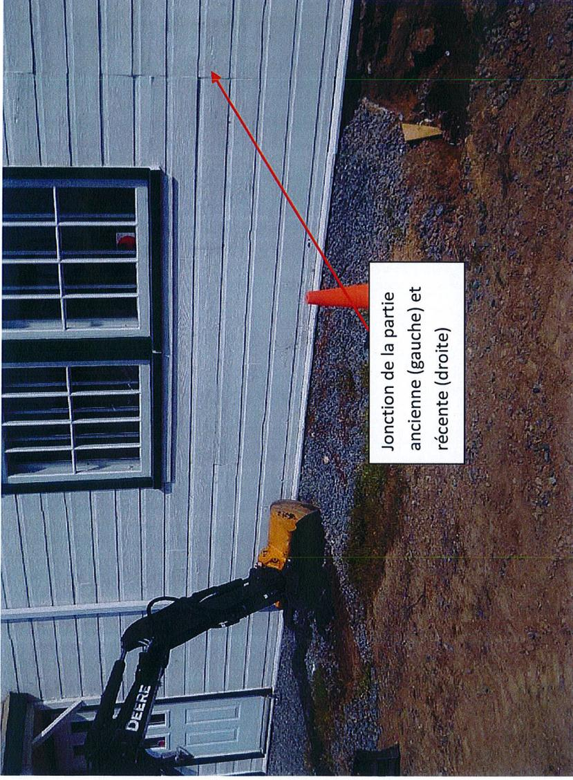
Photographie n° 3 – Jonction entre la partie ancienne et récente (PU-02-14)
