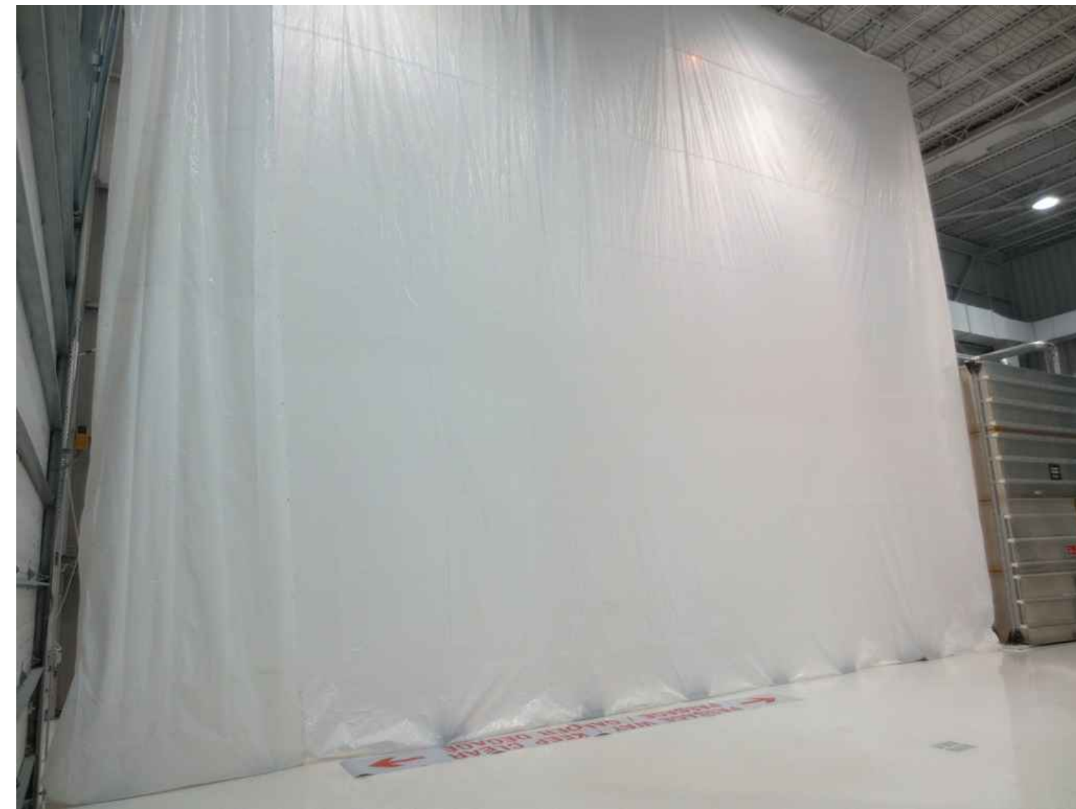
UNE BÂCHE TEMPORAIRE DOIT ÊTRE INSTALLÉE DANS LE LOCAL TRANSITOIRE DE LA ZONE DU PROJET, L'ENTREPRENEUR DOIT LA MODIFIER ET LA RENDRE ÉTANCHE COMME IL SE DOIT AVANT LA CONSTRUCTION.
