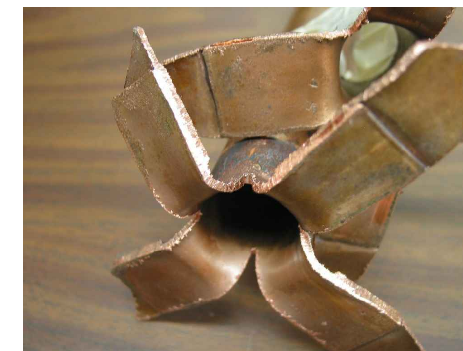
IMAGE MONTRANT UNE TUYAUTERIE BRASÉE À L'ARGENT 15 % SIL-FOS AVEC PURGE À L'ARGON. L'ENTREPRENEUR DOIT FOURNIR DEUX ÉCHANTILLONS SEMBLABLES POUR APPROBATION PAR L'INGÉNIEUR.
