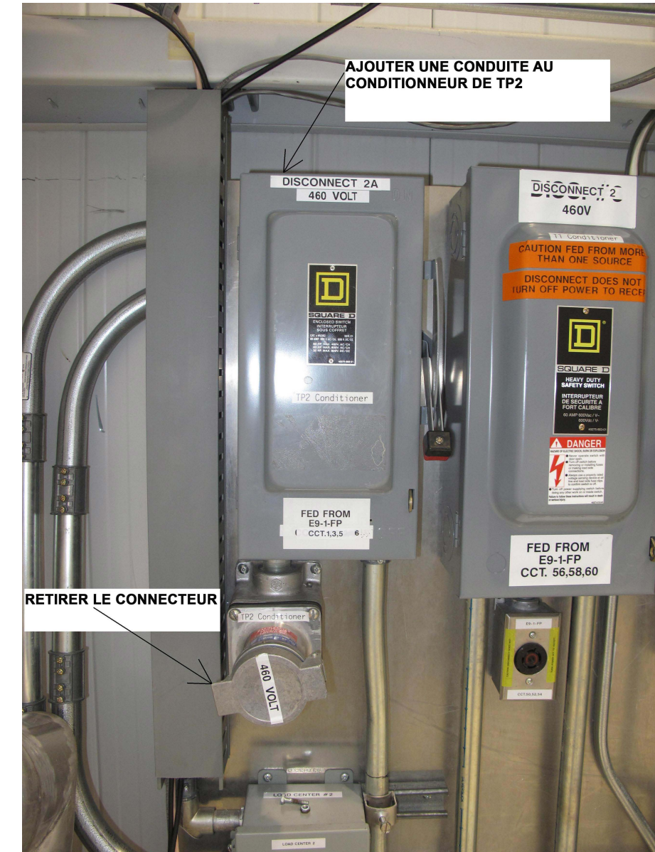
DÉBRANCHER LE CONDITIONNEUR DE TP2 VUE 2 E1
