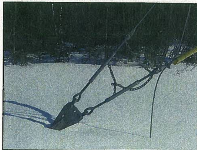
Photo no. 6 – Ancrage d'haubans structuraux.
