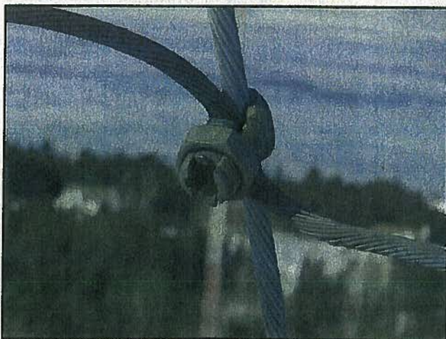
Photo no. 13 – Système de mise à la terre.
