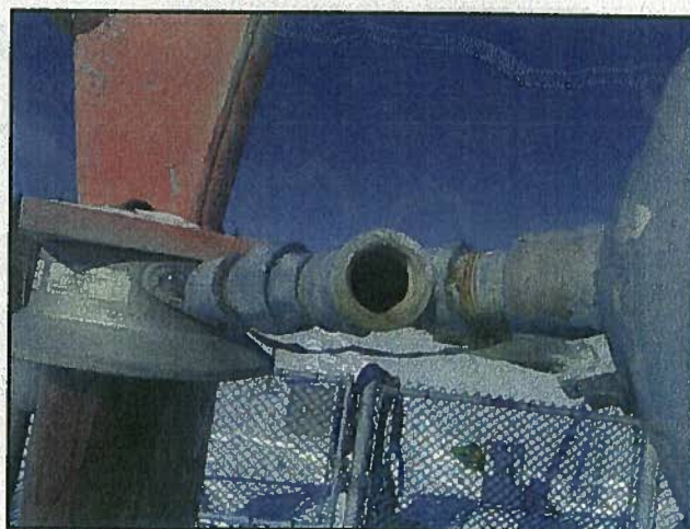
Photo no. 12 – Isolateur de la base du pylône.
