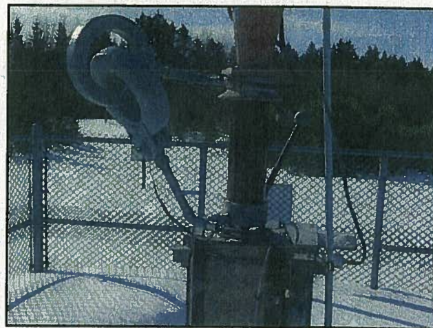
Photo no. 4 – Isolateur de la base du pylône.
