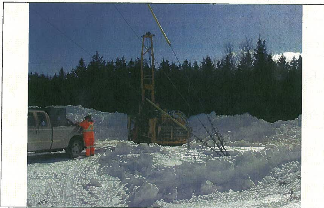
Photo no 3 : Foreuse sur le forage F-1 (mât)
