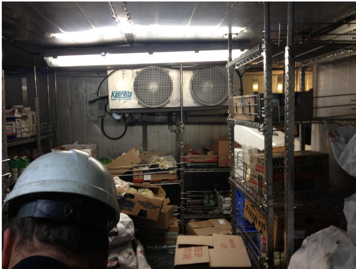
Serpentin de l'évaporateur de la chambre froide (à conserver)
