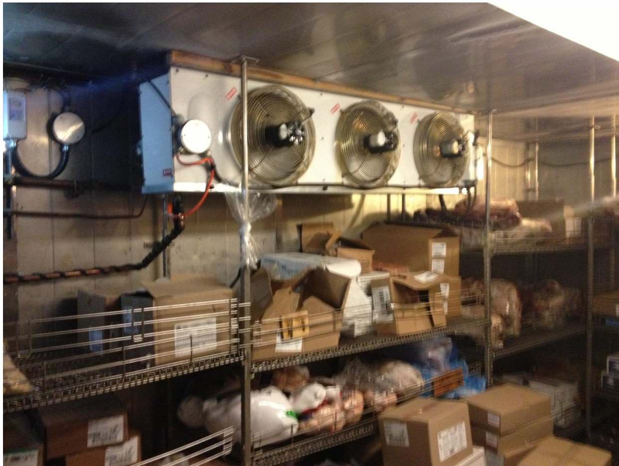
Serpentin de l'évaporateur du congélateur-chambre (à conserver)
