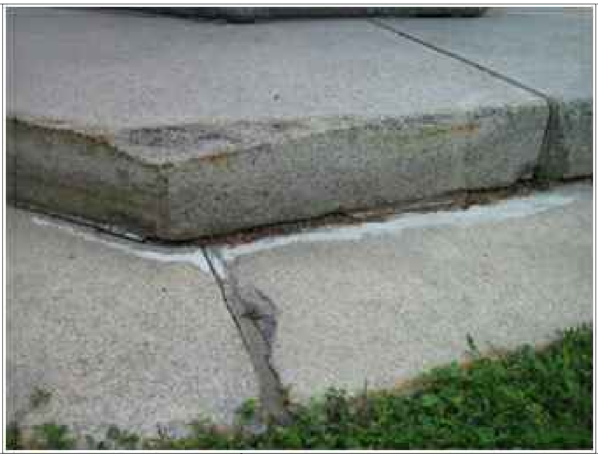
PHOTO RAPPROCHÉE DE LA BASE DE MAT DE DRAPEAU - PIERRE ENDOMMAGÉ CLOSE-UP OF WEST FLAGPOLE BASE - DAMAGED STONE
