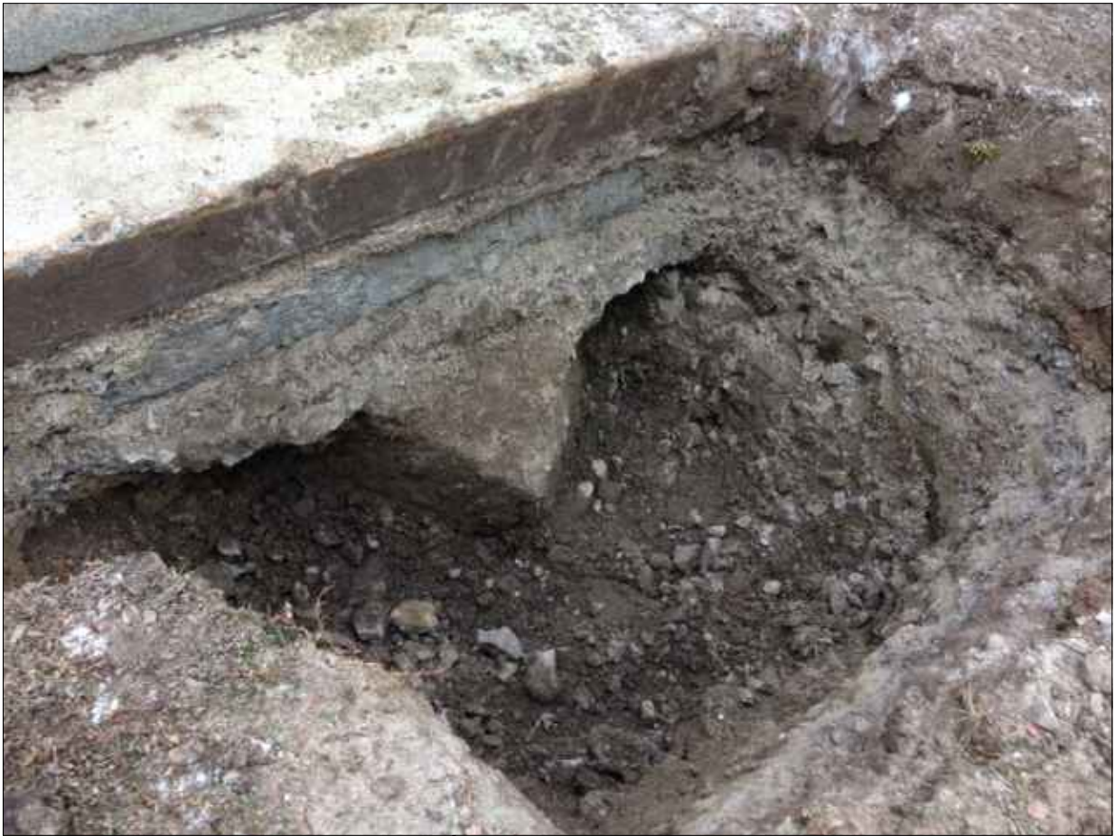
FONDATION EXPOSÉ DE LA BASE DU MAT DE DRAPEAU EXPOSED FOUNDATION OF FLAGPOLE BASE
