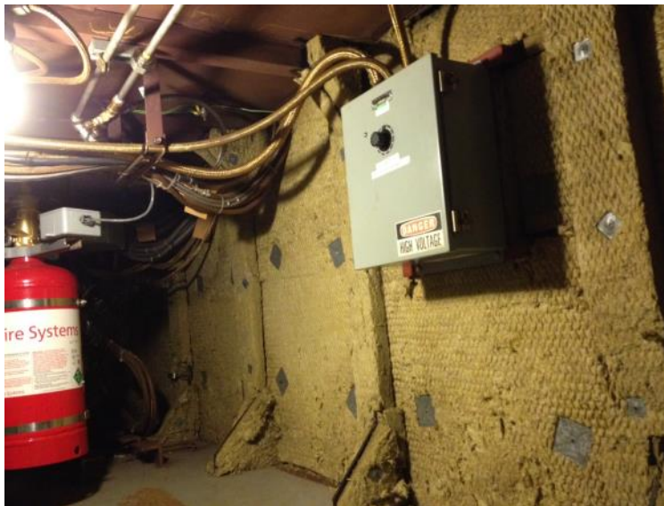
Photo 50.1 – Panneau de commande du projecteur dans la galerie de pont
