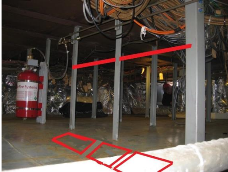
Photo 50.2 – Emplacement suggéré des bases de transformateur et de l'installation de support horizontal dans la galerie de pont sous la passerelle. Cette vue est vers tribord, d'arrière vers l'avant.
