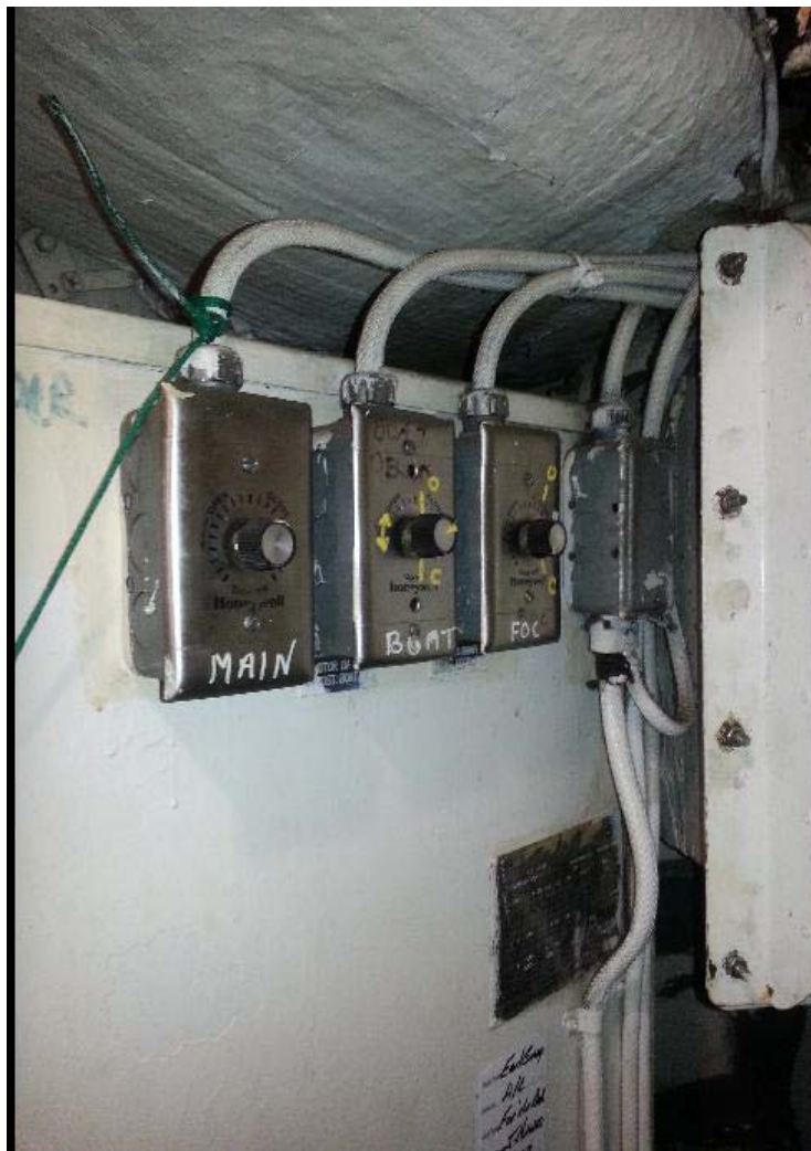
Image 36.1 – Interrupteurs de commande de registre
