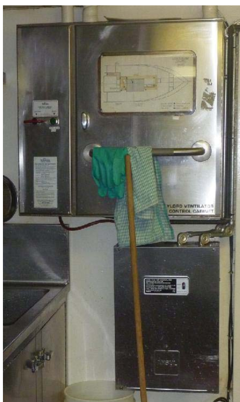
34.3.2.2.12 Armoire de commande de la hotte d'extraction et système d'extinction des incendies
