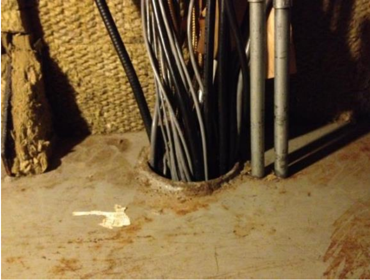
Photo 50.4 – Chemin de câbles existant entre la salle de l'équipement électronique et la galerie de pont.
