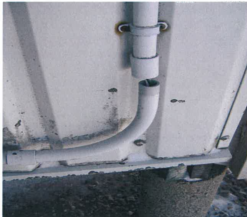
Photo #31: Broken Conduit
