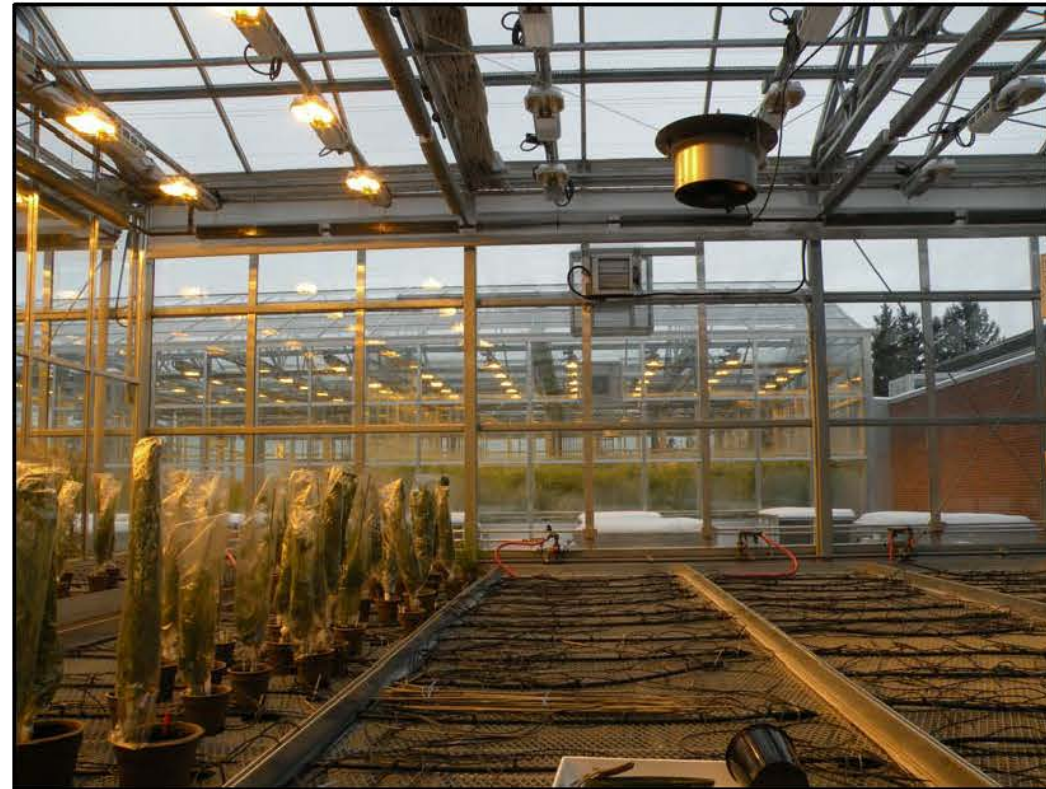
Bay 2 - West Elevation / Baie 2 - Façade Ouest
