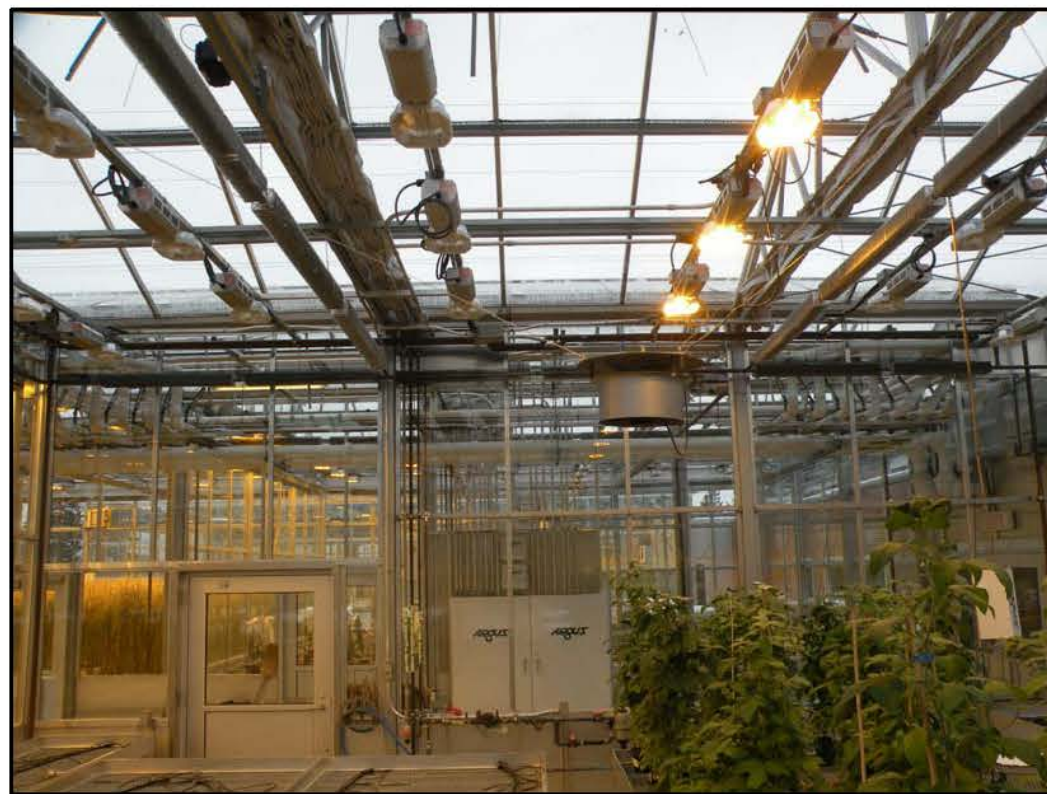
Bay 1 - West Elevation / Baie 1 - Façade Ouest
