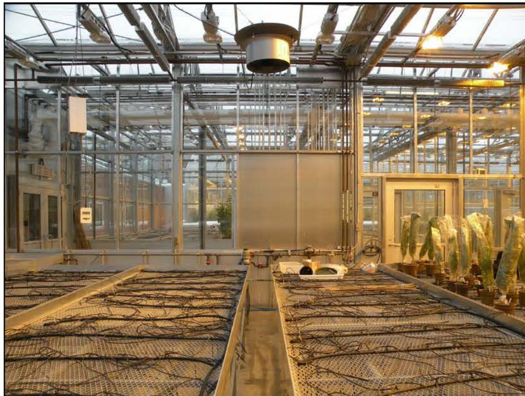
Bay 2 - East Elevation / Baie 2 - Façade Est
