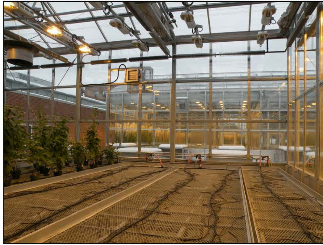
Bay 1 - East Elevation / Baie 1 - Façade Est
