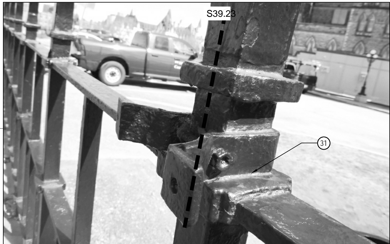
9 A303 BRACKET REPAIR - S39.23 TRAVAUX DE RÉPARATION DE CROCHET - S39.23 NTS / P. A.É.
