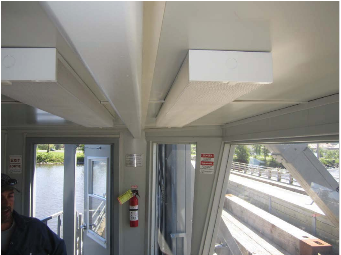
Figure 12 – Appareil de levage, intérieur de la cabine de commande, vue du plafond en regardant vers la gauche. Noter la barre au plafond en les lampes fluorescentes sur laquelle des petits ventilateurs de circulation réglables peuvent être installée pour souffler de l'air sur la fenêtre.
