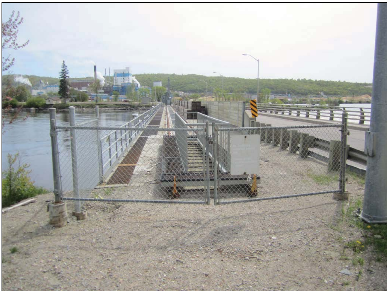
Figure 16 - Culée droite du barrage de l'Ontario. Les travaux sur l'appareil de levage auront lieu à cet endroit pendant que l'appareil y sera immobilisé tout juste devant le chariot de dégivrage qu'on peut apercevoir dans la présente photo.
