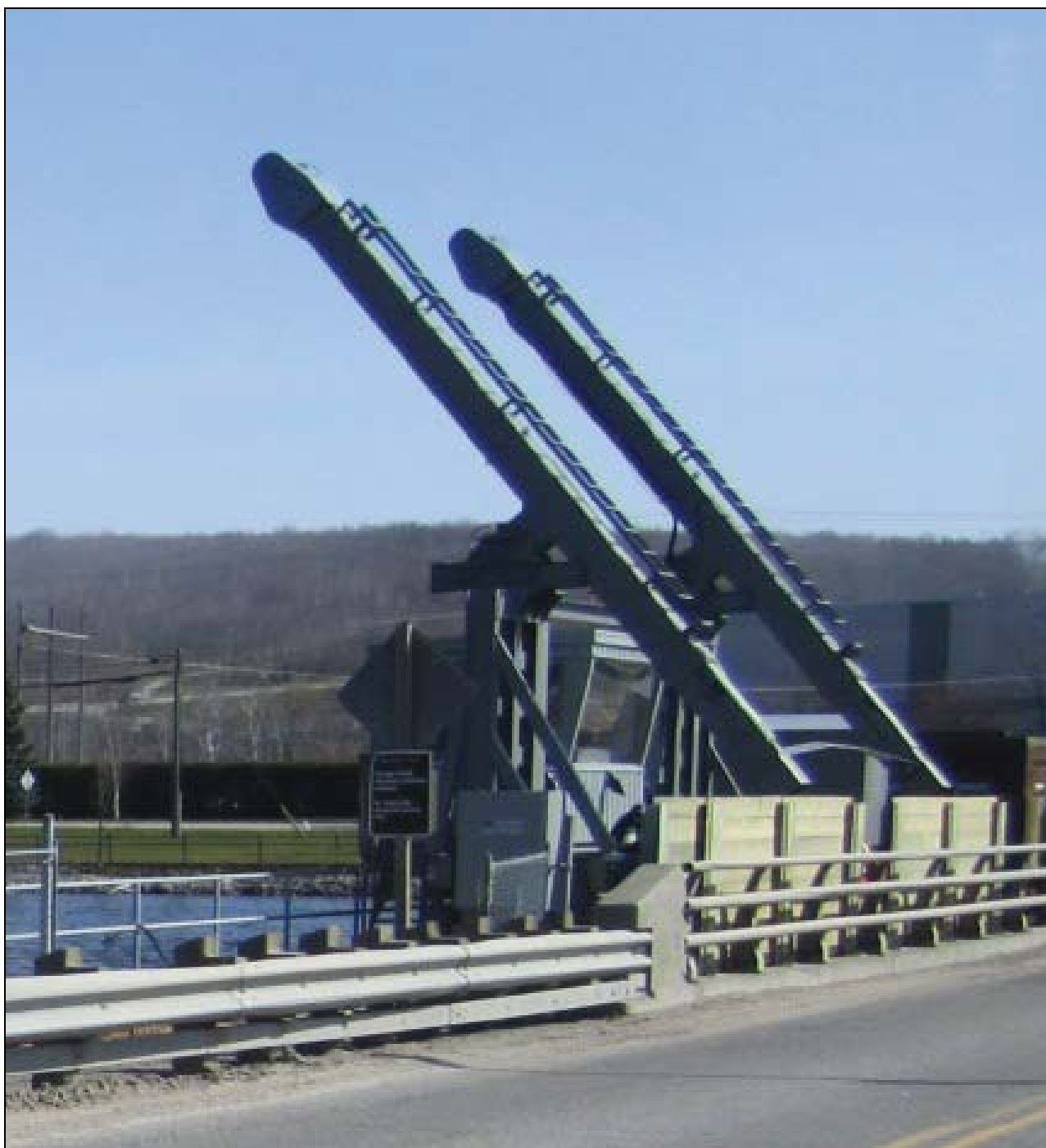
Figure 6 – Appareils de levage de poutrelles du barrage de l'Ontario l'angle de flèches quand elles lèvent des poutrelles de la pile sur le tablier opérationnel.
