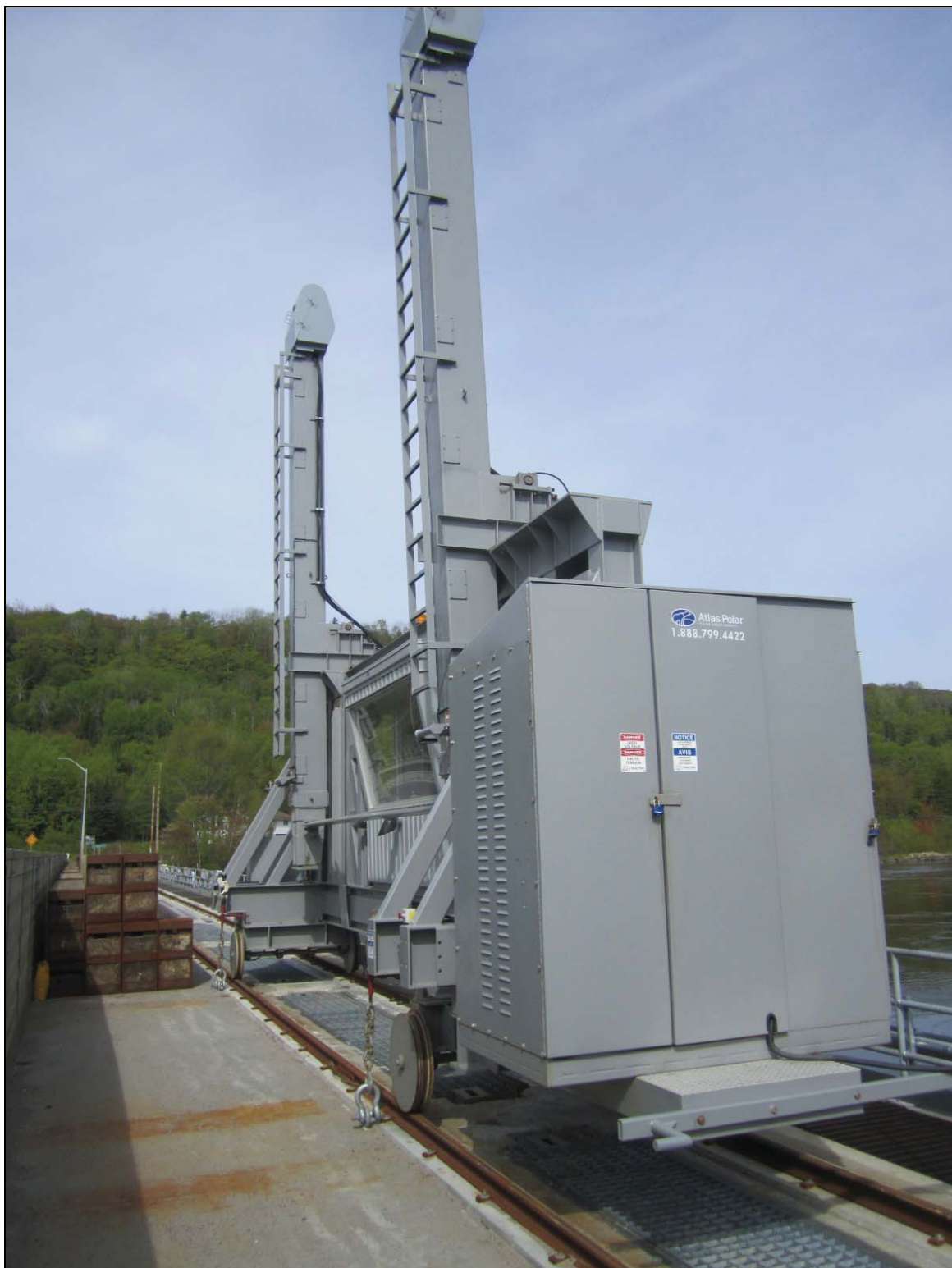
Figure 3 – Extrémité gauche de l'appareil de levage de poutrelles du barrage de l'Ontario, et côté aval.
